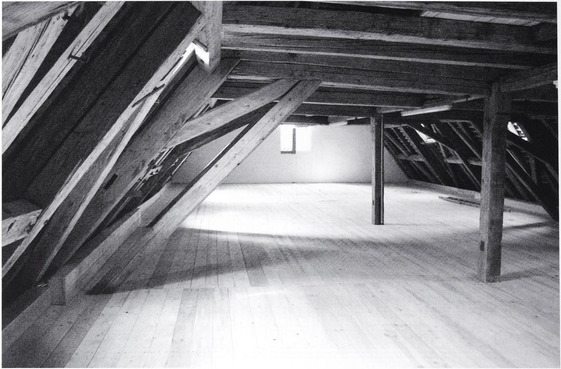
Abb. 8: Neckarzimmer, Rathaus. Das 2. Dachgeschoss aus dem Jahr 1657 mit seitlichem Sprengwerk und mittlerem Hängewerk, das durch den Ausbau des 1. Dachgeschosses um 1750 deaktiviert wurde.
