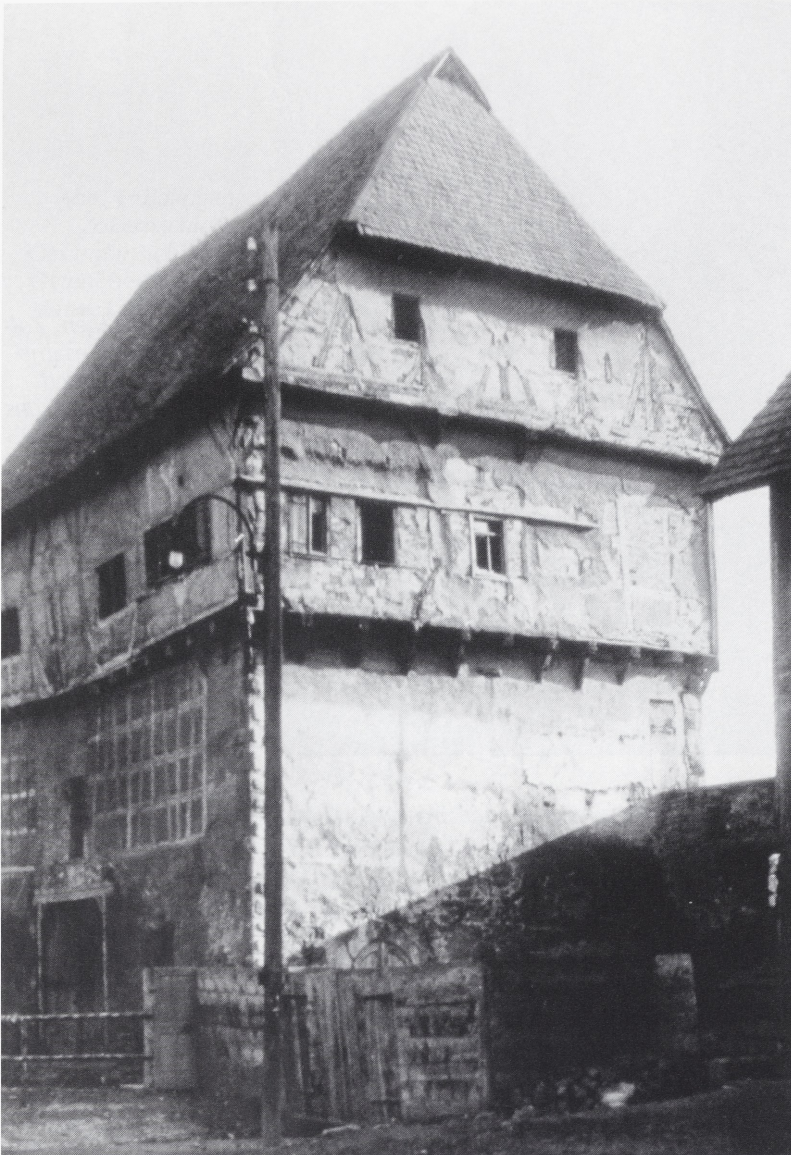
Abb. 3: Balingen, Zollernschloss. Ansicht des Hauptgebäudes von Nordwesten vor dem Abbruch 1935.
