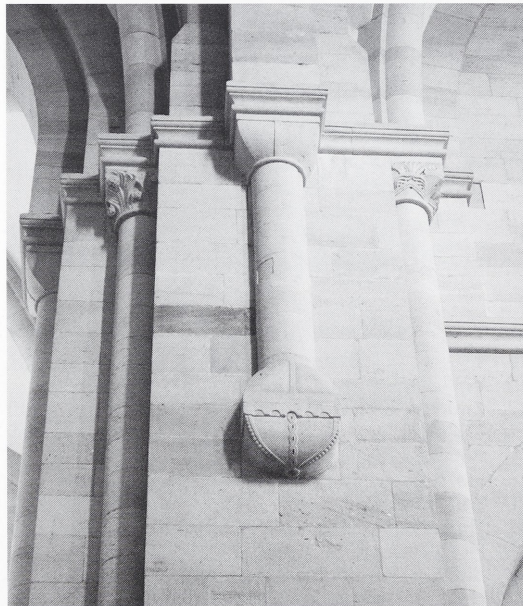
Abb. 13: Wandsäulen vor kantigen Vorlagen. a (rechts oben) Hesse (Lothringen), nordwestlicher Langhaus-Pfeiler der ehemaligen Benediktinerinnenkirche; b (rechts) Otterberg, Kr. Kaiserslautern, südwestlicher Vierungspfeiler der ehemaligen Zisterzienserkirche.
