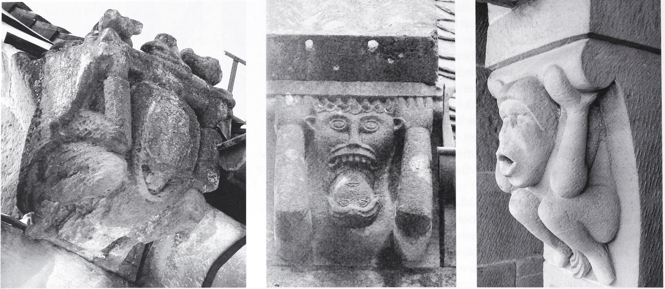
Abb. 16: Atlanten an Konsolen und Kämpfern. Von links nach rechts: a Gnadental, Klosterkirche, Nordkonsole des Sanktuariums-Giebels; b Boxberg-Wölchingen, Main-Tauber-Kreis, nordwestliche Konsole des Nordquerarm-Giebels der ehemaligen Johanniterkirche St. Johann; c Schwäbisch Hall, Schallarkade im Westturm der Großkomburg (ersetzt).
