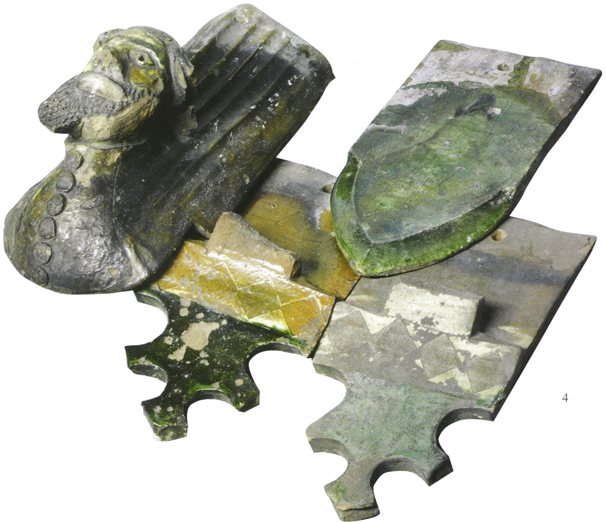
Ravensburg, Grüner Turm. 1 Flächenziegel der ursprünglichen Deckung. a Aufsicht, b Untersicht. – 2 Traufziegel, Aufsicht. – 3 Gratenziegel Typ I. – 4 Gratenziegel Typ I mit Traufziegel und Flächenziegel.
