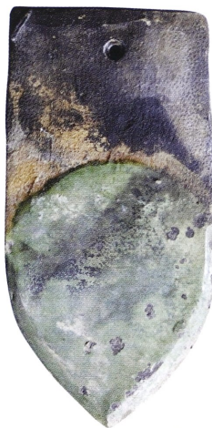
Ravensburg, Grüner Turm. 1 Gratziegel Typ I. – 2 Gratziegel Typ II. – 3 Gratziegel von Georg Huber. – 4 Reparaturziegel aus dem letzten Viertel des 18. Jhs., signiert Johann Jakob Nabholz. – 5 Wiederverwendeter mittelalterlicher Gotischschnitt. a Aufsicht, b Untersicht.
