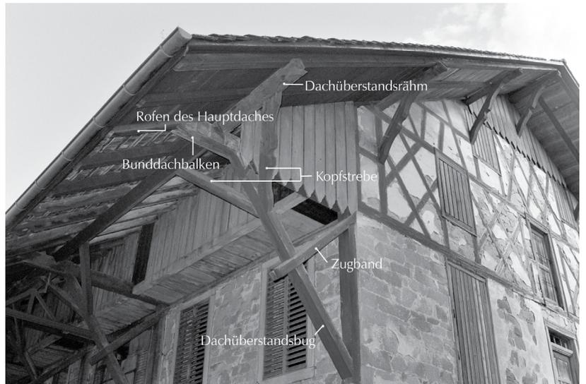
Abb. 217: Dachüberstand mit zusätzlicher Stützkonstruktion. Schleithelm (Kt. Schaffhausen), Bahnhofstr. 15, Stallscheune, um 1900.
