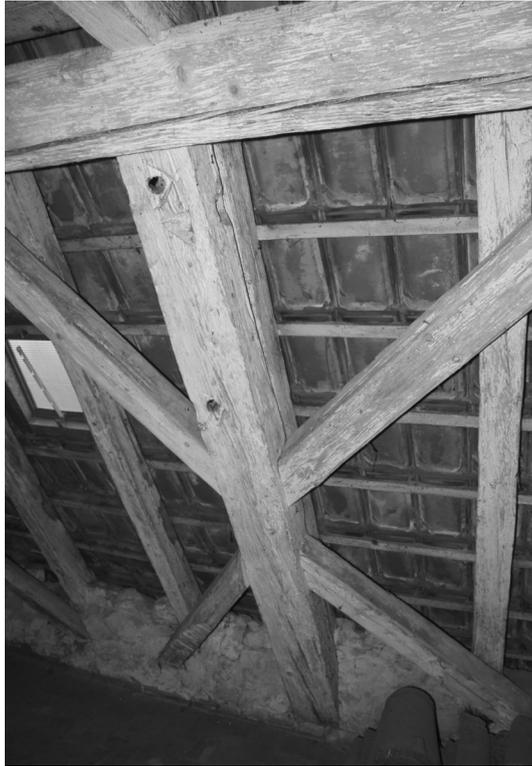
**Unterzug:** lastaufnehmender, zwischen Auflagern quer zur Balkenlage und unterhalb derselben verlaufendes Holz, das nicht Teil eines Bundes ist; als lastaufnehmender Balken bei Bohlendecken regional auch **Sohlbalken** genannt.
