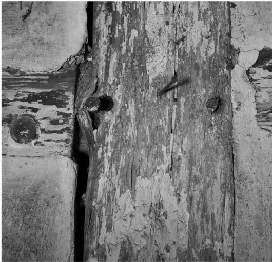
die Gefahr des **Ausknickens** zu berücksichtigen. Bei einer Druckbelastung quer zur Faser ergeben sich schon bei verhältnismäßig geringen Belastungen **Quetschungen** des Materials, und bei Zugbelastung quer zur Faser kommt es früh zu einem **Ausreißen** der Fasern. In der Praxis bedeutete dies, dass große Kräfte möglichst längs der Faser und damit in Richtung des Balkenverlaufes eingeleitet wurden.
