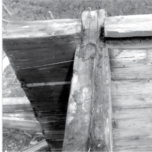
Abb. 96 (rechts): Kantholzblock mit Hohlkehle für Dichtungsmaterial.
