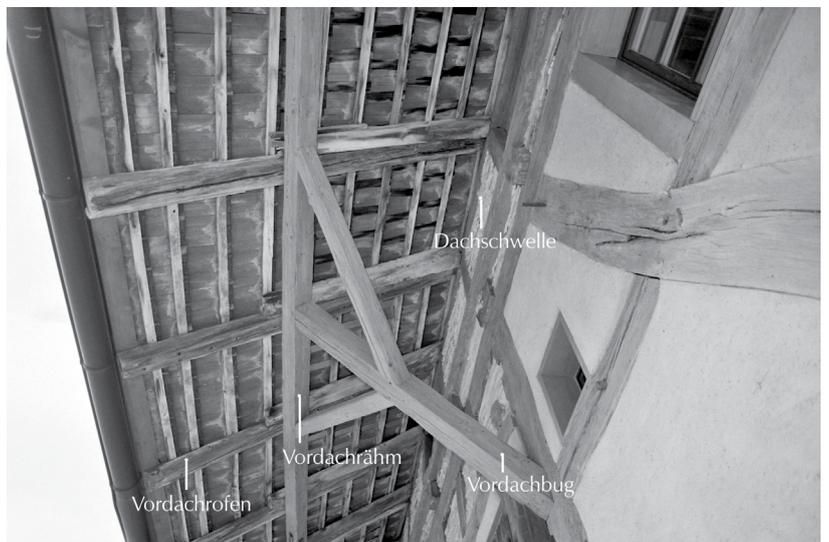
Abb. 220: Vordach an einem Massivbau. Guntmadingen (Kt. Schaffhausen), Heuengasse 6–8, 17./18. Jh.
