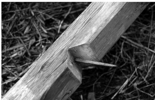
kämmung wird die Verschiebung der Hölzer durch verschiedenartig ausgeformte Einschnitte, die **Kammstege (Kämme)** und die **Kammstize**, verhindert. Die Hölzer sind in der Verbindungsstelle wenig im Querschnitt reduziert und besitzen so eine hohe Lastübernahmefähigkeit. In dieser Querschnittreduzierung und darin, dass die Hölzer in zwei Ebenen liegen, unterscheidet sich die Verkämmung von der Verblattung und der Verschränkung.
