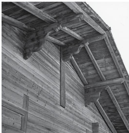
Abb. 99 (rechts): Blockkonsolen (Pfettenkonsolen) kombiniert mit Mantelständer.
