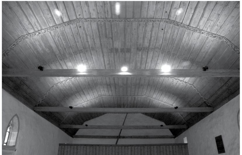
Abb. 227: Integriertes längsgerichtetes Holzgewölbe ohne eigene Gerüsthölzer. Liebfrauenkirche, Mühlacker-Lienzingen (Enzkreis), 1478/82 (d).
