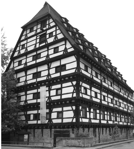
Das einstockig mehrgeschossige Traufgerüst kann entweder giebel- oder traufseitig oder an beiden Seiten geschosshohe Auskragungen durch vorkragende Decken- oder Stichbalken aufweisen. Dazu können entweder die Außenbünde des mehrgeschossigen Teilbereichs, an dem die Auskragung erfolgen sollte, stöckig mit **Stockwänden** abgebunden oder auf den auskragenden Decken- und Stichbalken unabhängig vorgesetzte Bünde abgezimmert sein.
