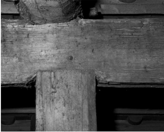
Abb. 78: Ausreißen der Faser durch Zugbelastung.
