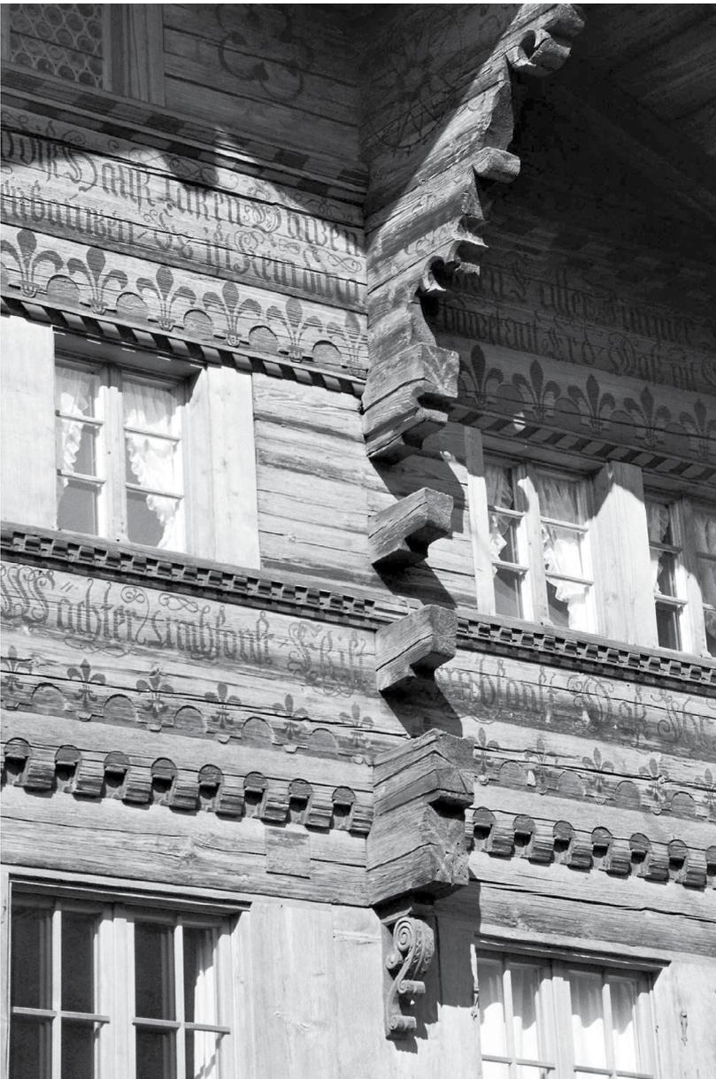
Abb. 247: Knagge mit diagonalem Rundstabprofil. Zug (Kt. Zug), Chamerstr. 120, 1606.
