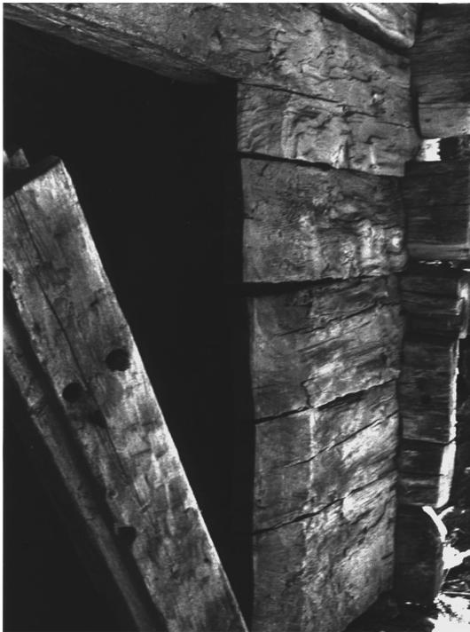
Bei Wandlängen von mehr als 5–6 m und bei Giebeln braucht es Stabilisierungen (Queraussteifungen) in Form von einbindenden Querwänden, Stummelwänden, Mantel-/Schalenständern, Mantelstielen, eingebundenen Ständern/Stielen und Blockzangen, um Bauchungen zu verhindern.
