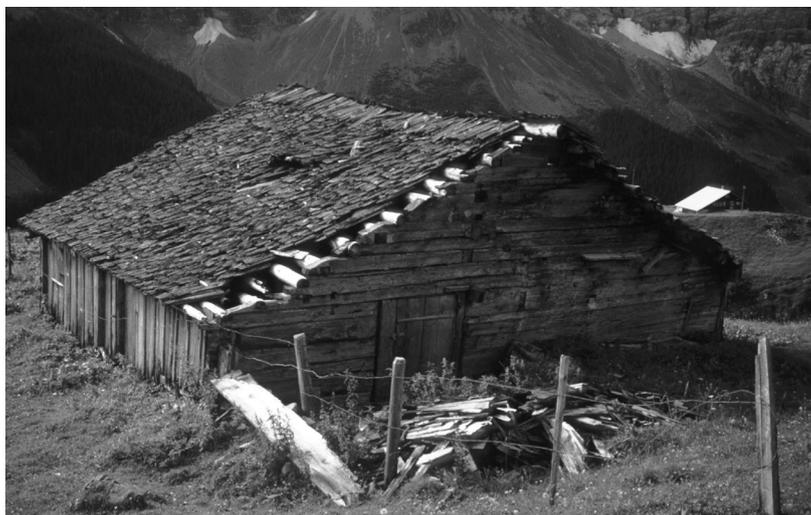
Abb. 124 (unten): Blockdach, halb zerstört. Unterschächen (Kt. Uri), um 1850.
