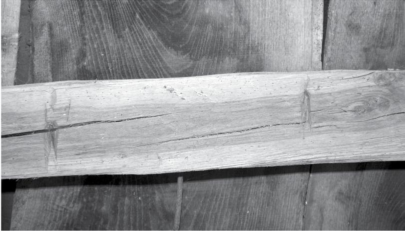
Abb. 30: Zu tief geratene Kerben durch eine Schrotaxt im geglätteten Balken.
