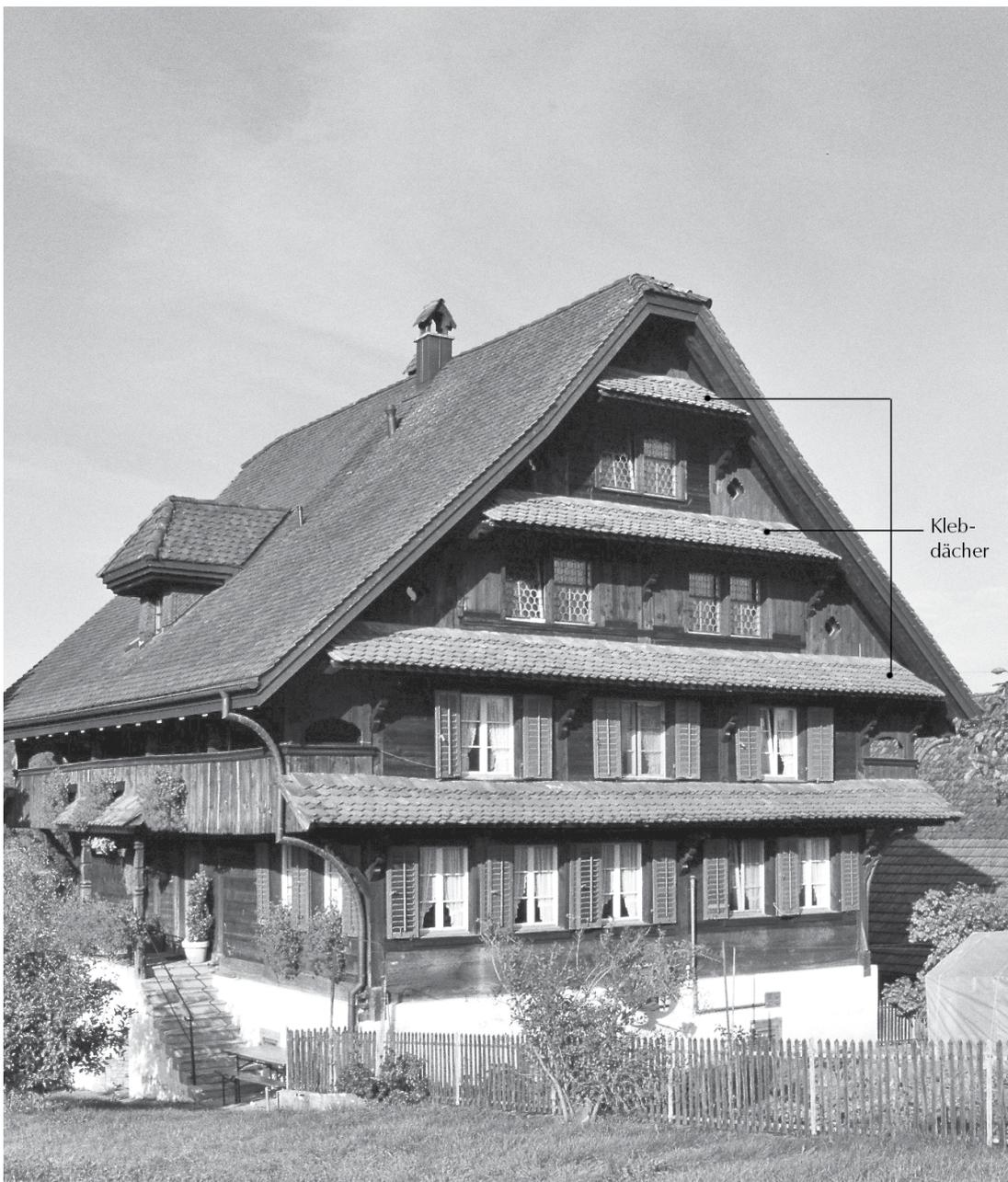
Abb. 223: Konstruktion eines Klebdaches.
