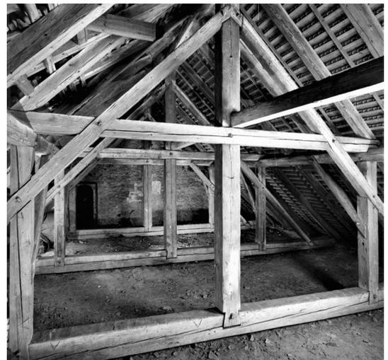
Abb. 202: Das Sparrendach mit quer eingebundenen Sparrenpaaren wird durch drei Kehlbalkenlagen in drei Dachgeschosse und einen Spitzboden unterteilt.
