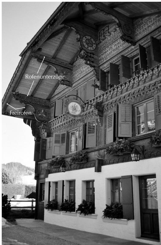
Abb. 214: Giebel-seitiger Dachüberstand mit Freirofenpaar an einem Holzmassivbau. Rouge-mont (Kt. Vaud), Route de Saanen, 1810.
