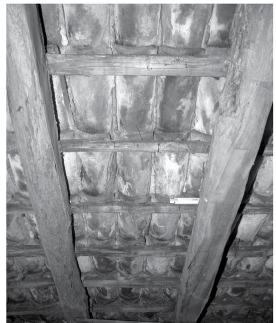
Balken können bei unterschiedlichen Seitenlängen des Querschnitts breitkant oder hochkant verbaut werden.
