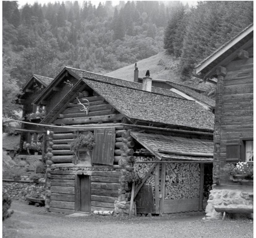
Abb. 87: Rundholzblock (links) und Kantholzblock (rechts angeschnitten). St. Martin, Gde. Pfäfers (Kt. St. Gallen).
