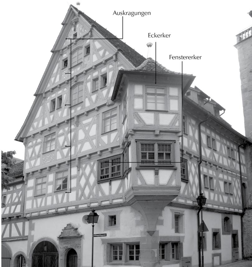
Abb. 232: Gestaltung durch Kubatur: Eckerker, Auskragungen, Fenstererker. Markgröningen (Lkr. Ludwigsburg), Wimpelgasse 2, 1599 (d).
