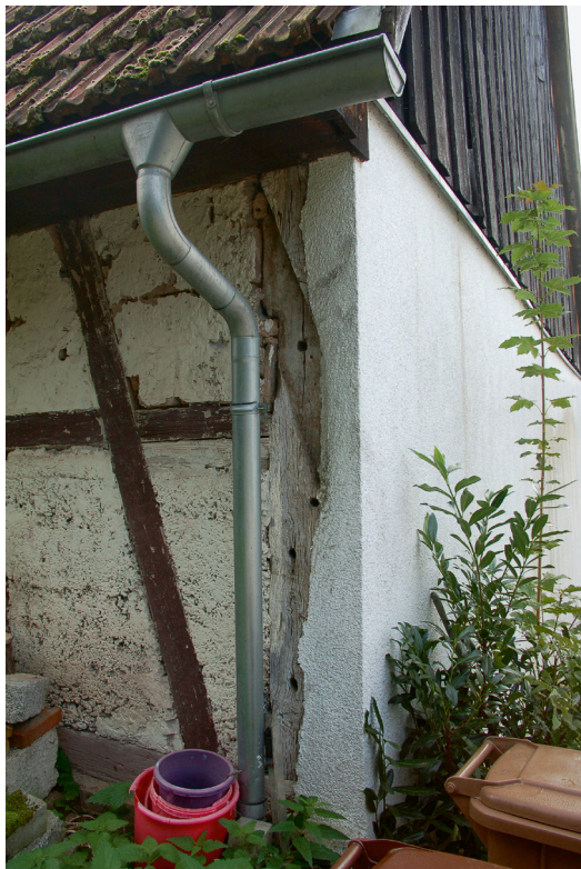
19 Zizishausen, Im Höfle 22–22/1. Freiliegender mittelalterlicher Eckständer mit Blattsasse der einstigen Aussteifung an der rückwärtigen Traufseite der Scheune.
