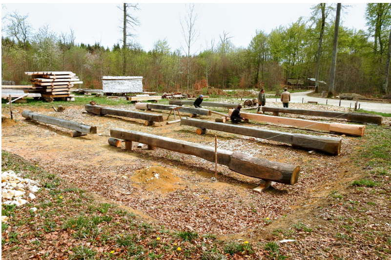
13 Scheune des Campus Galli bei Meßkirch: Auslegen der 2019–2020 bearbeiteten Eichenpfosten des Innengerüsts (oben); Erstabund im Laufe der Saison 2020 (unten)
