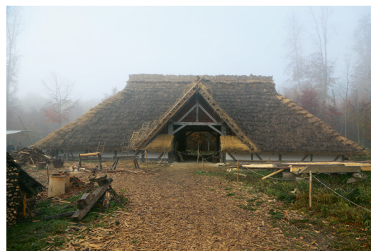
15 Scheune des Campus Galli bei Meßkirch: Abzimmerung in Einzelteilen durch Nutzung eines Baugerüsts von Mai-Juni 2021 (oben); Beginn der Dacheindeckung bereits vor Fertigstellung des Holzgerüsts im Juni 2021 (Mitte); fertig mit Roggenstroh eingedeckter Bau im Oktober 2021 (unten)
