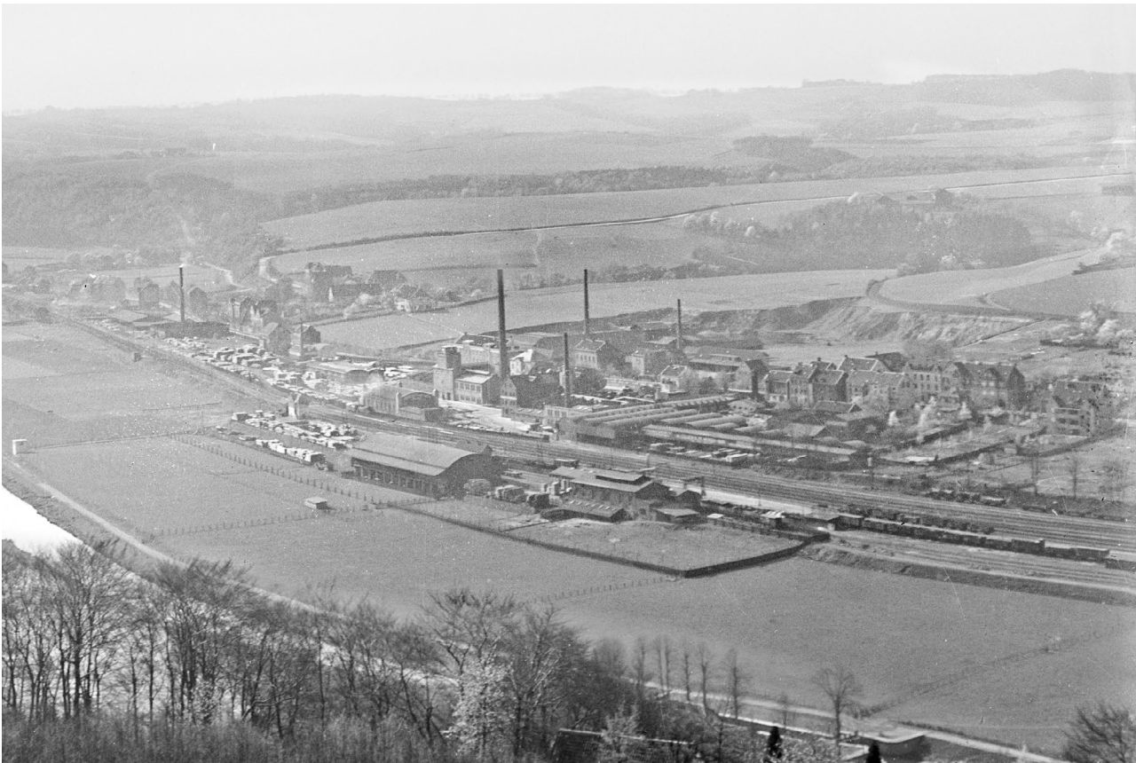
Abb. 7: Das Werksgelände mit Kraftwerk, Maschinenhaus und Pumpstation an der Ruhr (ganz links) um 1925 Anton Meinholz/Fotoarchiv Ruhr Museum, Essen
