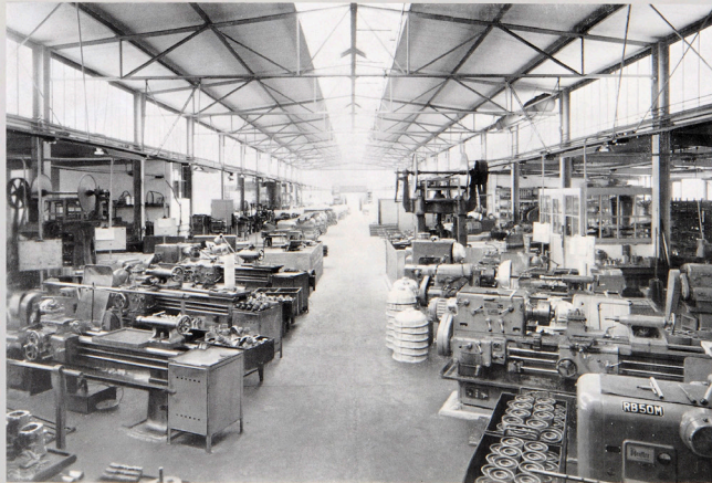
Ausschnitt aus einer Fabrikationshalle
