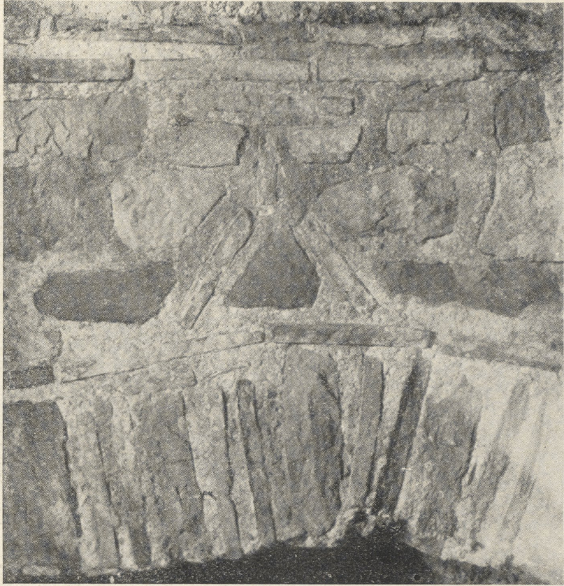
Abb. 12. Türsturz an der Außenfront von Halle I (Detail); darüber Ornament in Dreiecksform und Fugenverstrich
