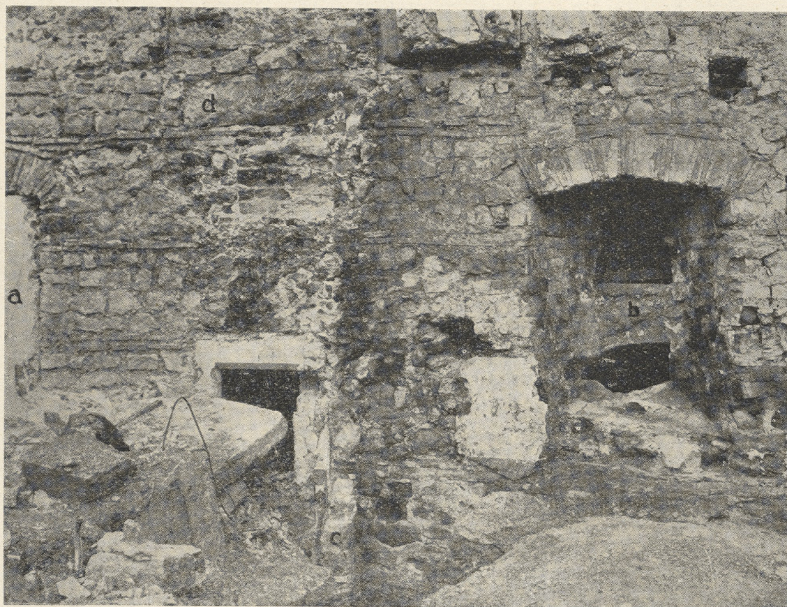
Abb. 9. Gliederung der Innenfront; Detail. Zwischen den Fensteröffnungen (a u. b) der zum größten Teil abgeschlagene Wandpfeiler, bei (c) noch bis zur Außenkante erhalten, mit dem ebenfalls abgeschlagenen Abdeckstein (d)
