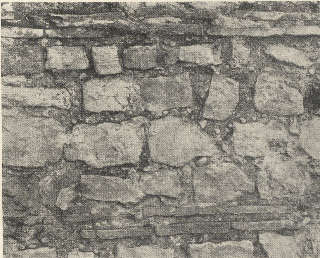
Abb. 7. Die Mauertechnik der Horrea. Innenfront von Halle I
