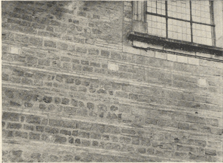
Abb. 12. Trier, Dom. Balkenlöcher der Fenstergalerie an der Nordseite des gratianischen Quadratbaues, von der Windstraße aus gesehen
