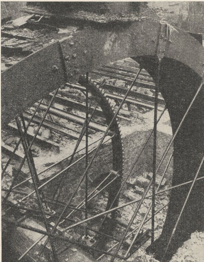
Abb. 9. Das Antriebsrad in der Wolfskaul (vgl. Abb. 8) während des Abbruchs.
