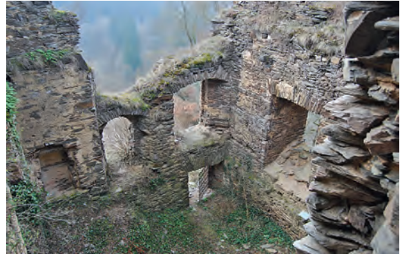
17 Ruine Trutz-Eltz. Südwestliche Innenecke des Wohnturmes.
