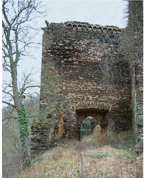
4 Ruine Trutz-Eltz. Innenansicht der Schildmauer.
