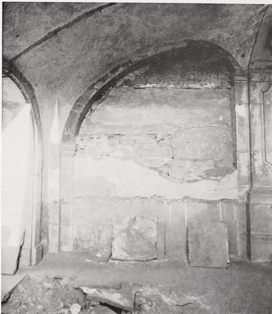
Abb. 3 Die Bogenkonstruktion der ersten Bauphase unter dem südlichen Treppenaufgang. Zustand 1955
