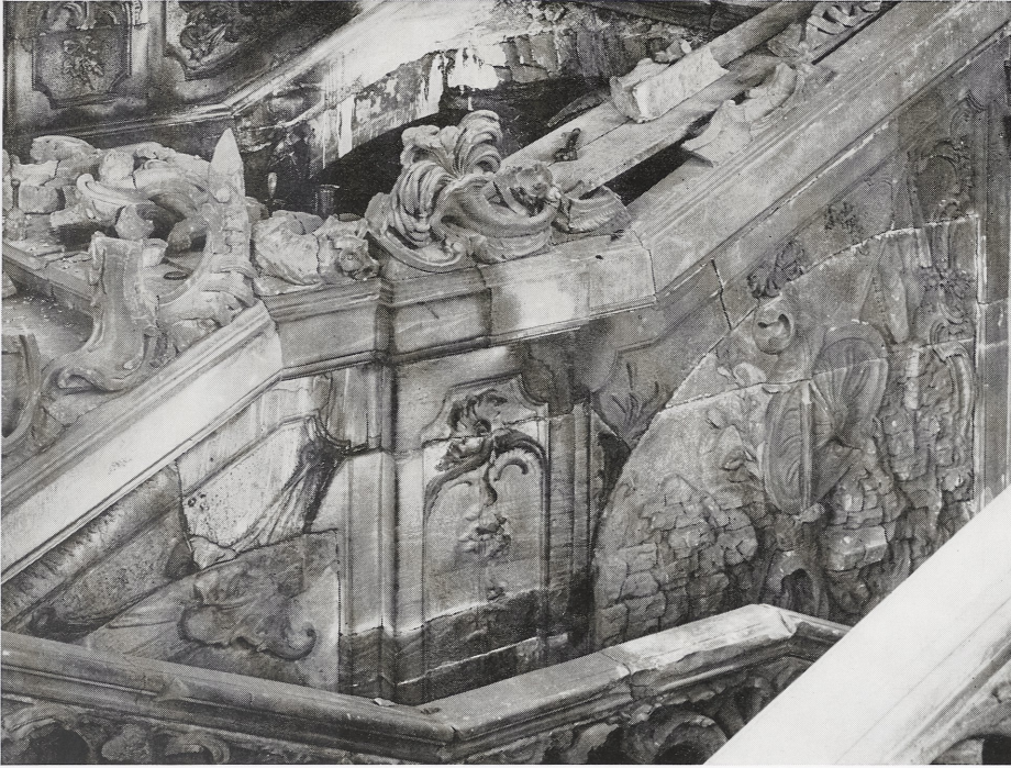
Abb. 2 Der obere Treppenlauf der Hofseite mit den Bögen der ersten Bauphase. Zustand während der Wiederherstellung 1947
