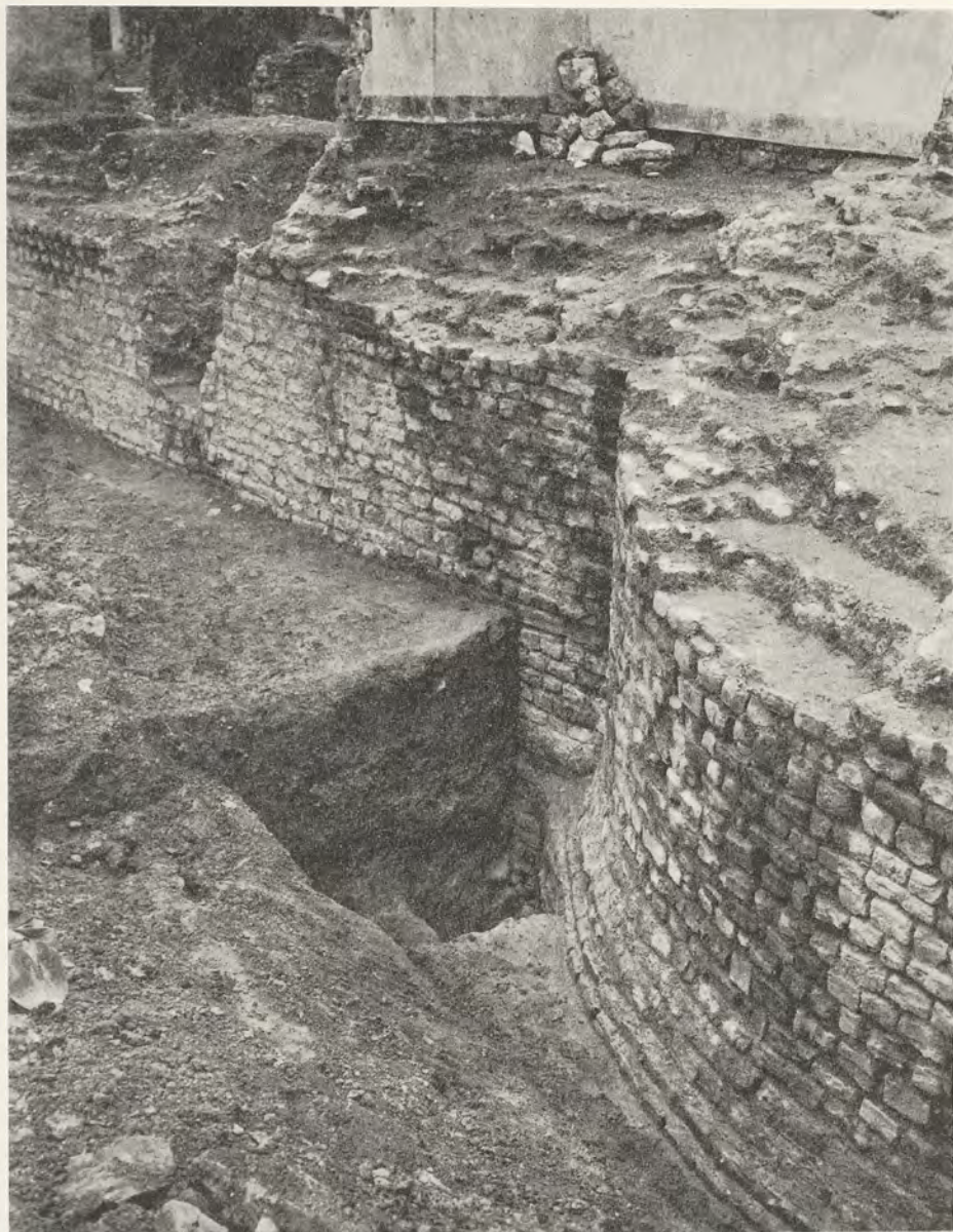
Abb. 119. Bitburg. Blick von Nordosten auf den Turm F mit dem anschließenden Mauerwerk nach Turm G hin
