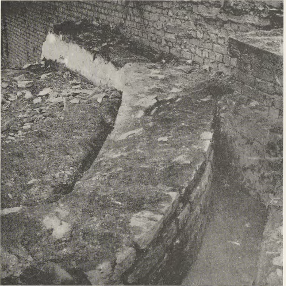
Abb. 96. Unterer Teil eines Turmes von der Kastellmauer in Neumagen
