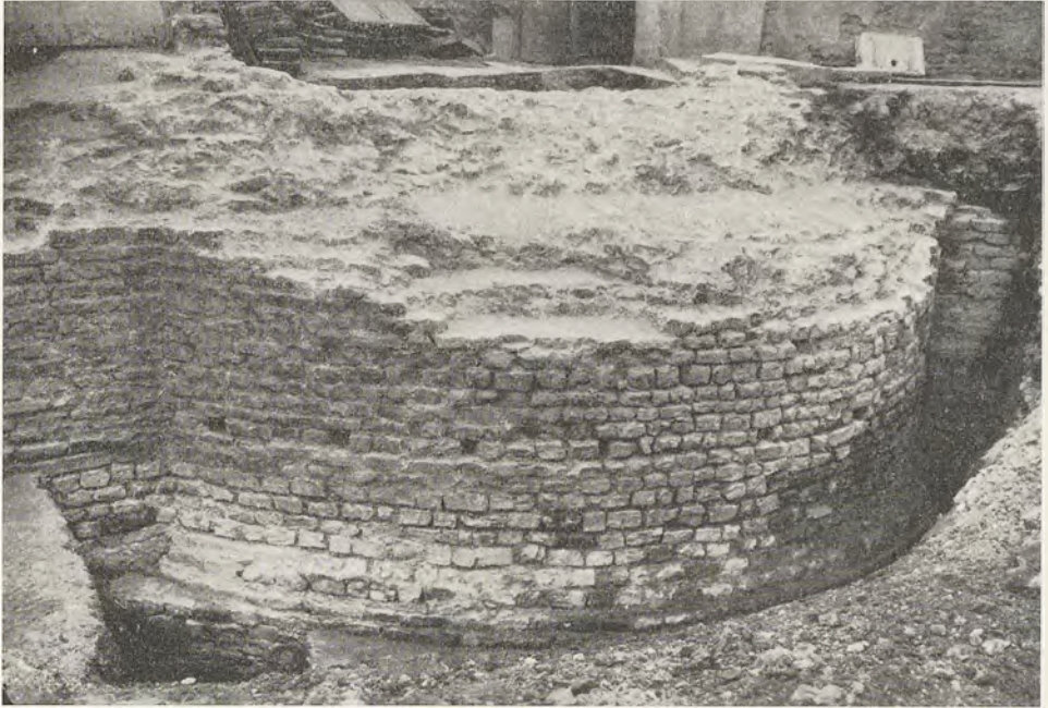
Abb. 120. Bitburg. Blick von Osten auf den Turm F mit Gerüstlöchern
