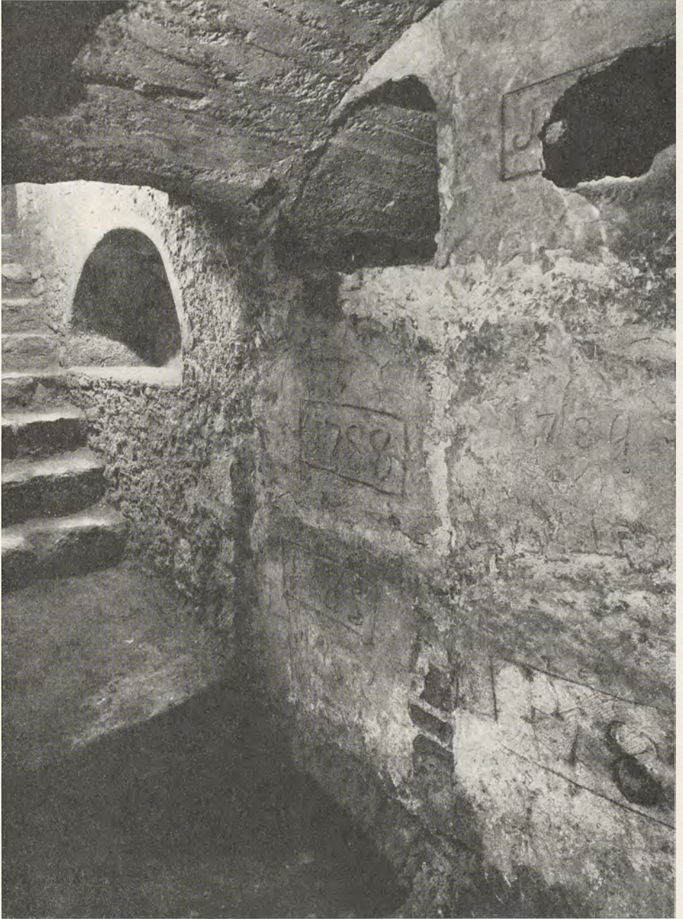
Abb. 180. Trier, ehem. Markuskloster. Teilansicht des Gruftraumes mit den noch größtenteils zugemauerten Bestattungsnischen
