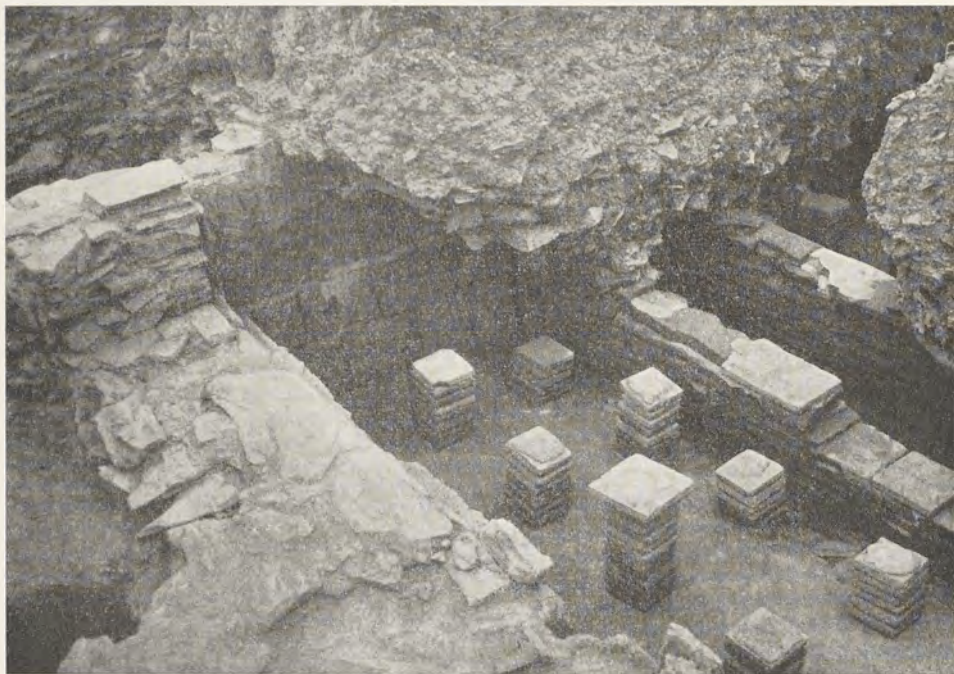
Abb. 154. Villa von Leuven. Blick von Südosten in die Heizungsanlage von Raum 28
