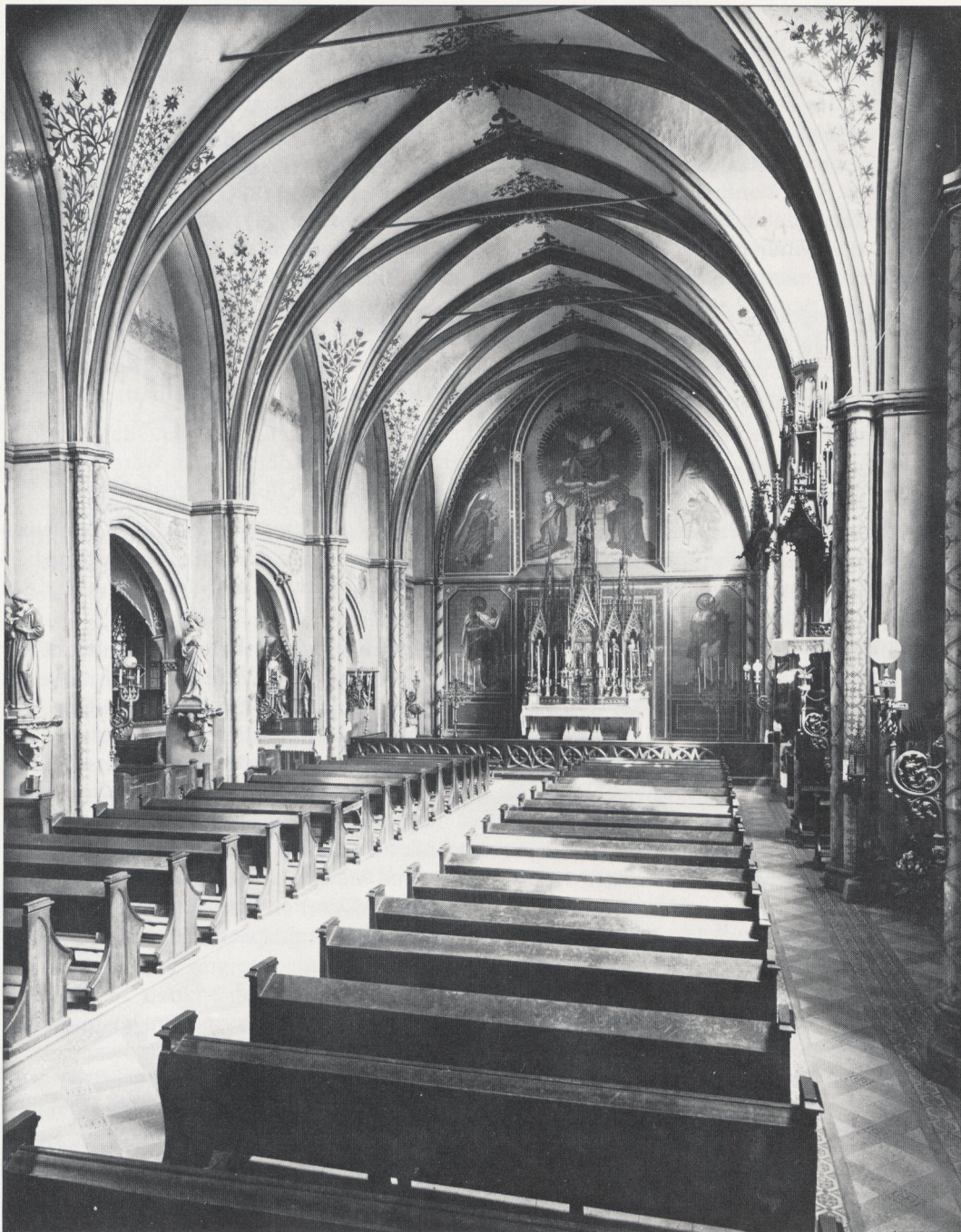
Abb. 1 Aufnahme von Wilh. Deuser, die den Zustand der St.-Gangolf-Kirche im ersten Jahrzehnt unseres Jahrhunderts zeigt. Der neugotische Altar verbrannte bei der Zerstörung im Dezember 1944
