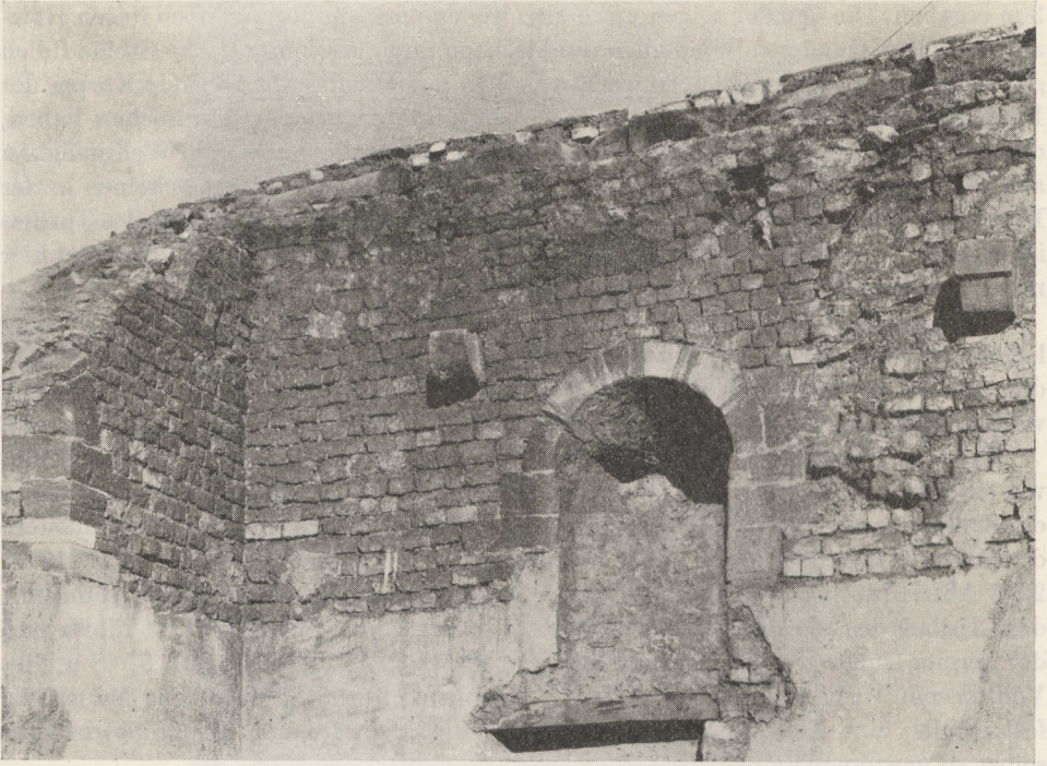
Abb. 46. Trier, Frankenturm. Alter Befund der Ostecke von innen vor der Aufstockung 1938.
