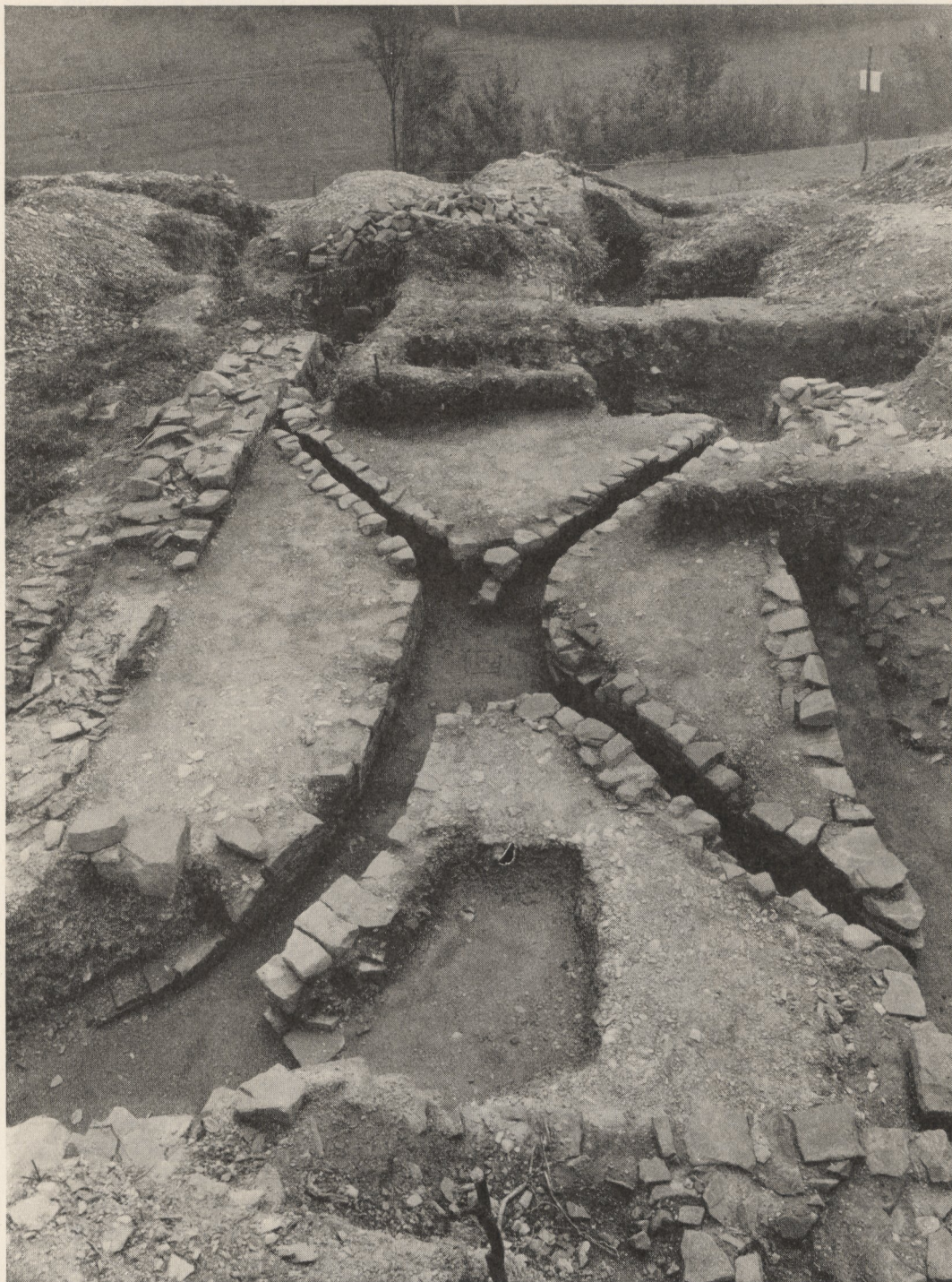
Abb. 32. Raum mit Kanalheizung in dem südlichen Eckbau (Gesindebau) des Guthofes der Rodung Irsch.
