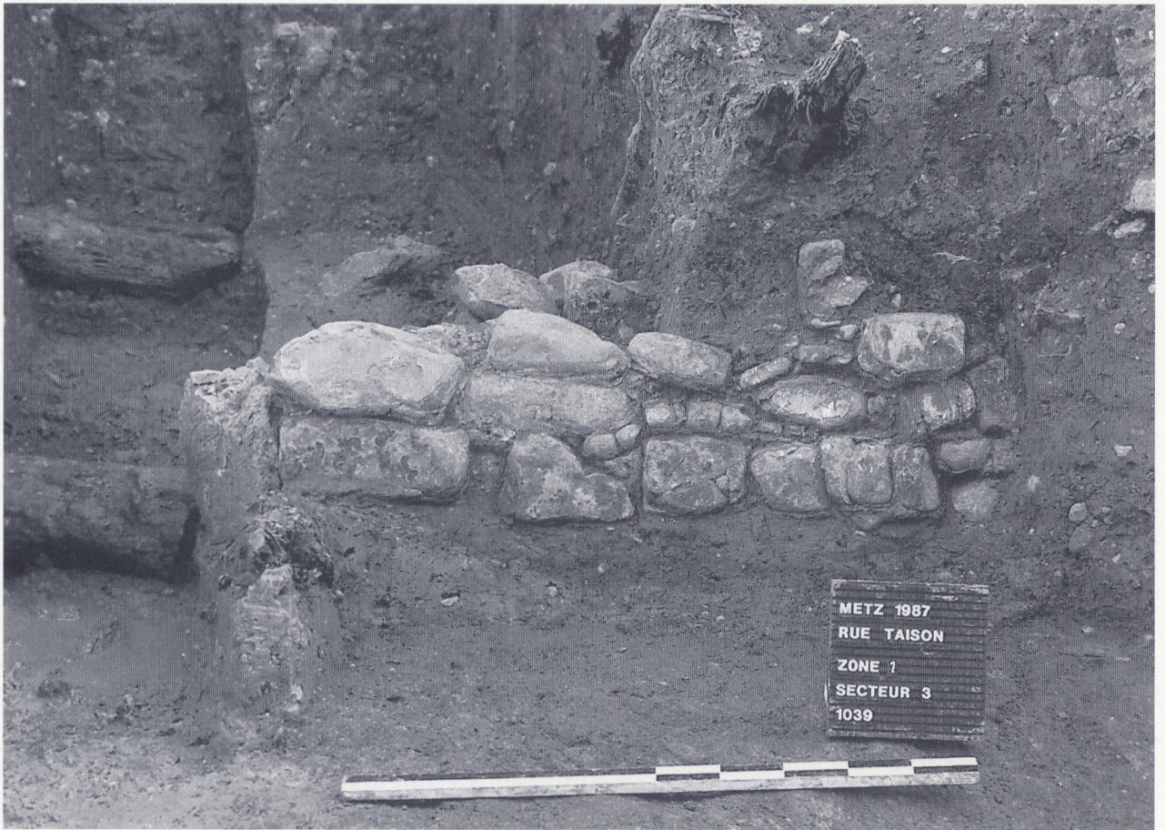
Fig. 13 et 14 Fondation du parement du Rempart 2
