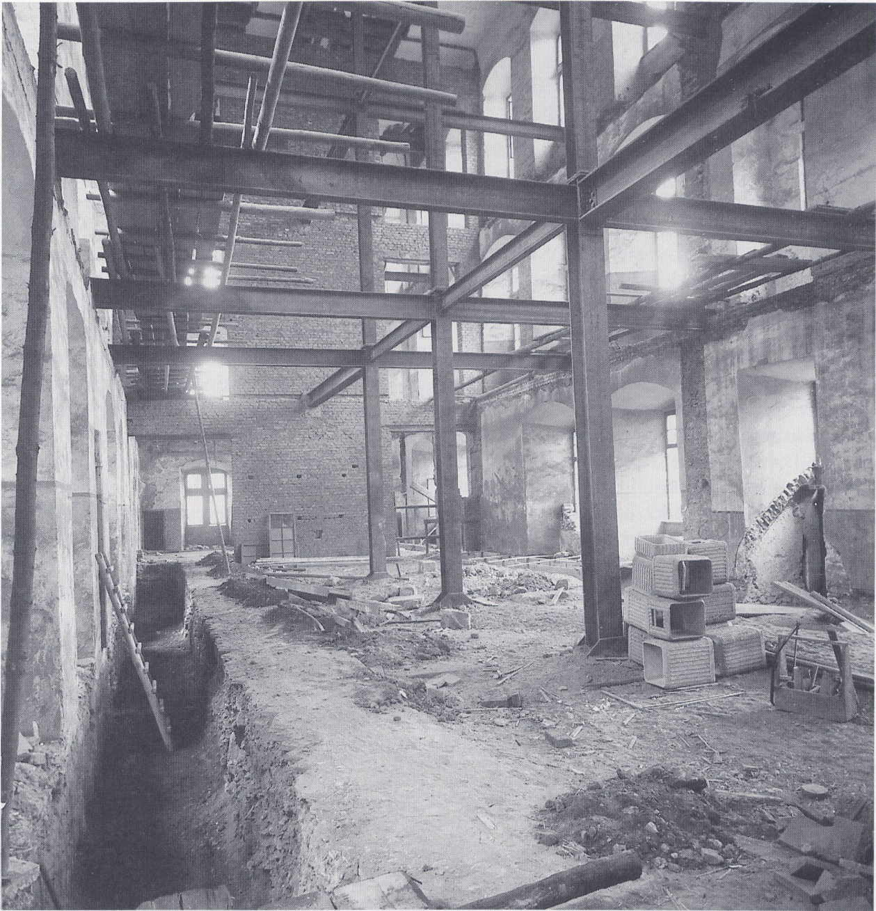
Abb. 3 Kurfürstlicher Palast in Trier. Im ausgekernten Südflügel ist bereits das Stahlgerüst zum Tragen der einzelnen Stockwerke des Großmuseums eingezogen. Zustand vom Juni 1938
