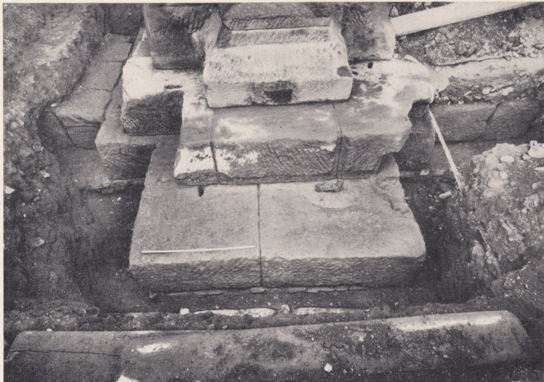
Abb. 4. Porta Nigra, Fundament des nördlichen Mittelpfeilers von N.
