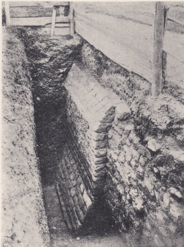
Abb. 11. Untere Ziegelstraße. Flickstück der Stadtmauer, Ansicht von innen.
