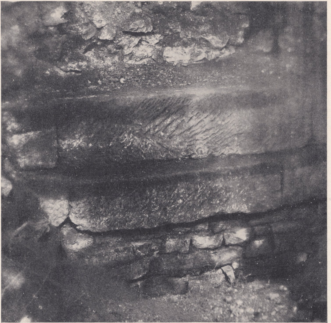
Abb. 5. Turm E. Äußeres Fundament.
