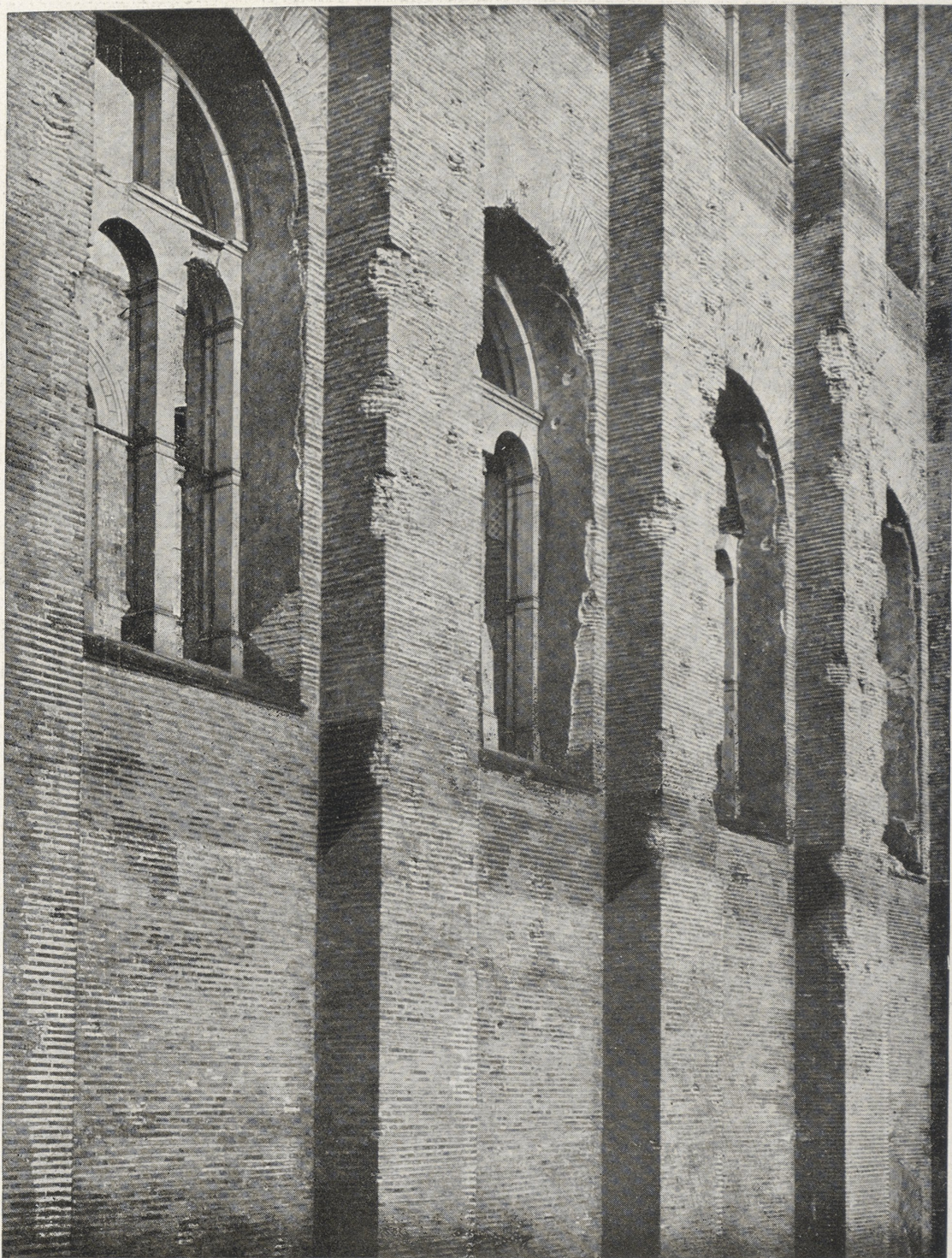
Trier, Basilika. Streifenförmige Verfärbungen an der westlichen Längswand (Leerstreifen im Wandverputz der unteren und oberen Galerie). Vgl. Abb. 7, 2 und 8, 1—2
