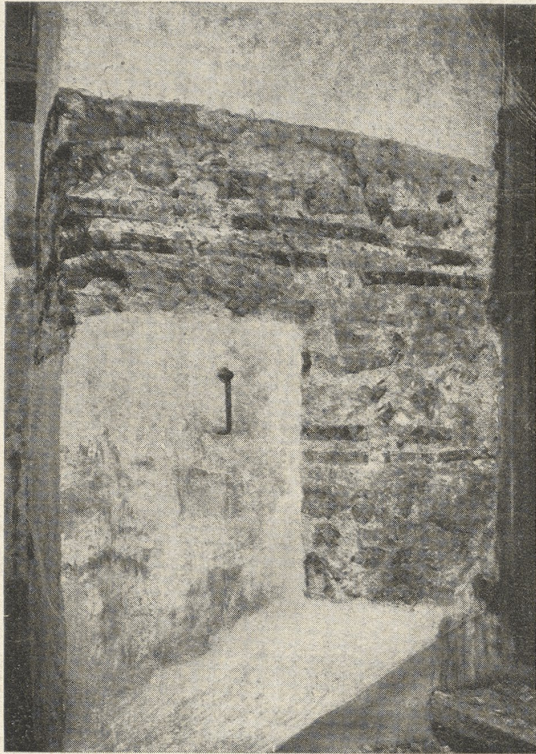
Abb. 10. Trier, Dom. Eingang zur spät-romanischen Krypta am Marienaltar: Freigelegtes Mauerwerk der Ostwand der spätantiken, quadratischen Halle
