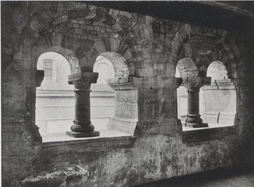
Abb. 3. Die Fenstergruppe des Frankenturms von innen.
