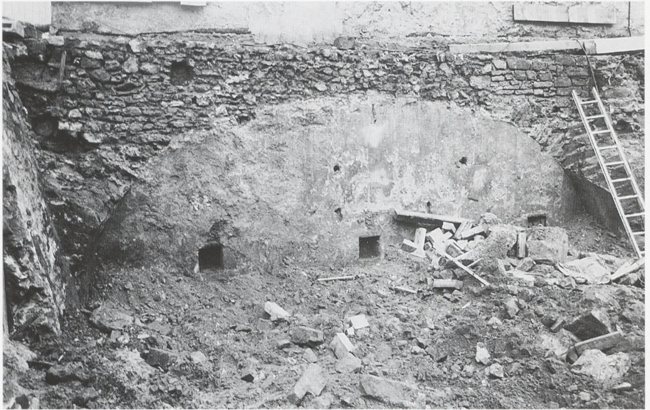
Abb. 3 Foto der mittelalterlichen Kellerwand aus antikem Abbruchmaterial mit Gewölbeansatz des 19. Jahrhunderts.
