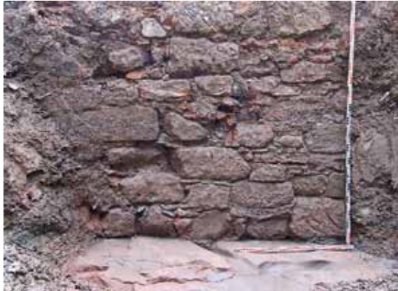
187 Wittlich, Feldstraße (nördlich von Nr. 10). Feldseitige Gründungssituation der spätmittelalterlichen Stadtmauer (Foto: J. Hupe, Digi-EV 2012,130/40).
