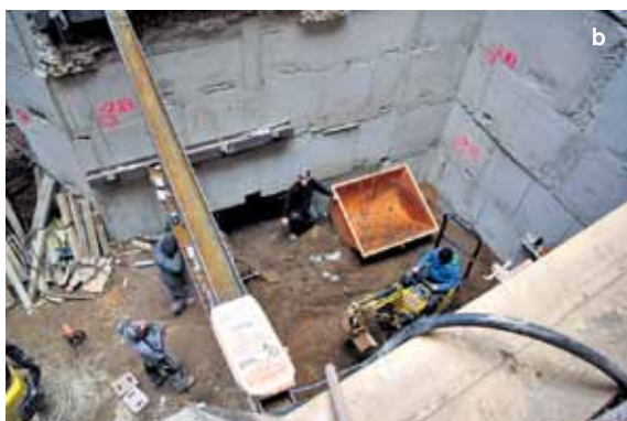
20 Trier, Glockenstraße 11. Ausgrabungen im laufenden Baubetrieb. a Archäologischer Profilschnitt im Gebäudeinneren, Blick nach Süden; b Betonunterfangungen des historischen Mauerwerks, Blick nach Südwesten (Fotos: Ch. Schaufert, Archäologieservice Neunkirchen. RLM Trier, Digi-EV 2016, 187/282; 361).
