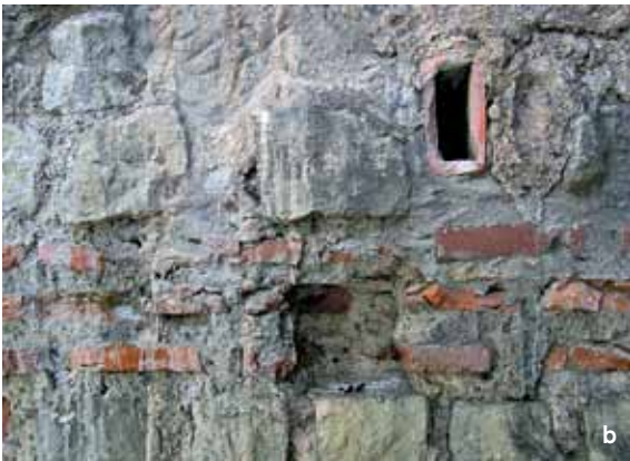
33 Trier, Kaiserthermen. Außenseite des Kesselraumes 5' mit horizontalen Tubuli im Mauerwerk, von Osten (Foto: M. Dodt, Digi-EV 2010,163/973c; 974).
