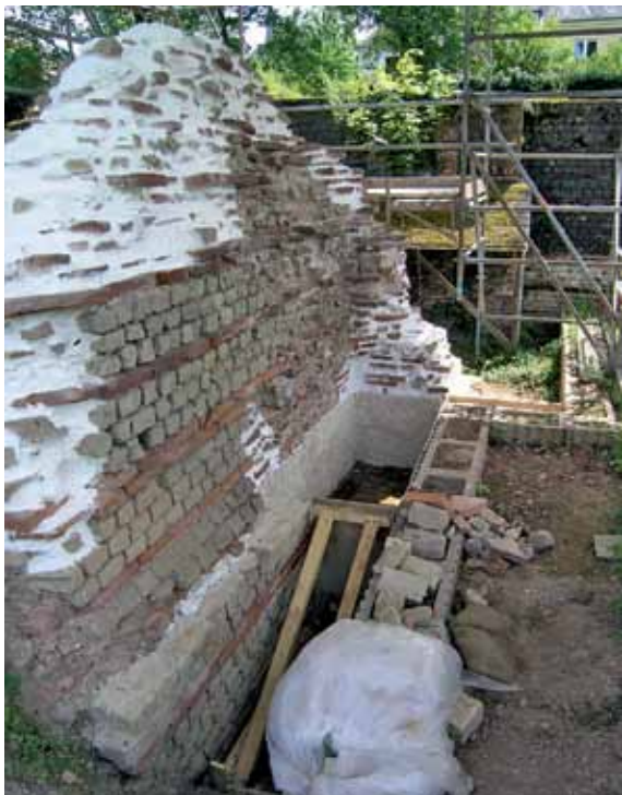
3 Trier, Barbarathermen. Südostecke des Caldariums während der Restaurierung und Sicherung des Opus-caementicium-Mauerwerks, Ansicht von Nordnordwesten (Foto: M. Dodt, Digi-EV 2014,154/134).
