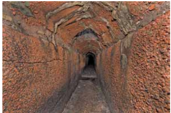
52 Trier, Südallee 25. Innenansicht des Kanals, Blick nach Norden. Im Gewölbe sichtbar eine Einstiegsöffnung, die im 19. Jh. zur Einleitung von Gerbereiabwässern angelegt worden war (Foto: Th. Zühmer, Digi-EV 2016,207/545).
