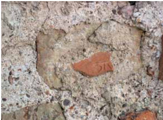
31 Trier, Kaiserthermen. Südostecke des Caldarium-Haupttraumes C. Gerüstloch und verfüllter Steinkopf mit Ziegelstück mit konstantinischem Stempel (Foto: M. Dodt, Digi-EV 2010, 163/975).
