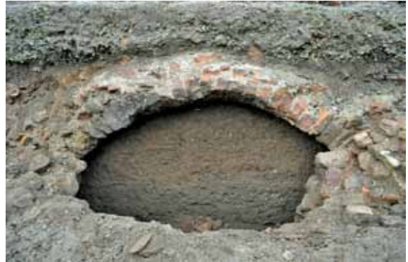
47 Trier, Südallee 25. Tonnengewölbe eines römischen Kellers an der Westseite der Straße E, Ansicht von Osten. Dem Gewölbe sitzt ein Betonfundament eines früheren Betriebsgebäudes der Gerberei Pies auf (Foto: B. Kremer, Digi-EV 2016,207/156).
