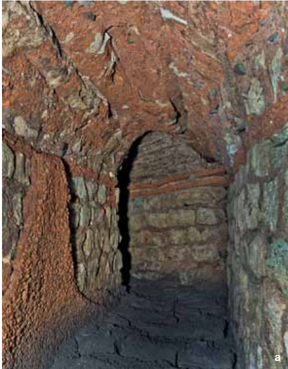
54 Trier, Südallee 25. a Zugemauerter Leitungsstrang. b Anschluss an parallel geführten Strang (Fotos: B. Kremer, Digi-EV 2016,207/579; 582).
