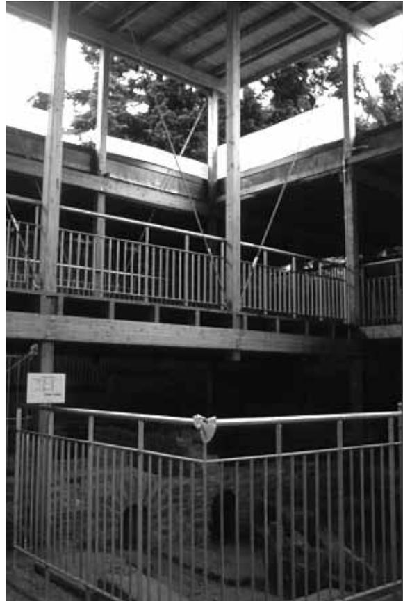
Abb. 14 Provisorische Vorrichtungen am Schutzbau über der römischen Villa Bollendorf sollen den empfindlichen Badetrakt vor Schrägregen schützen.
