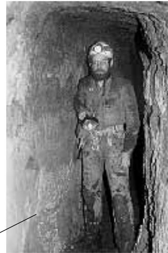
Abb. 10 Tunnel bei Pötz 7 im Bereich der abgeschrägten Tunnelsohle.
