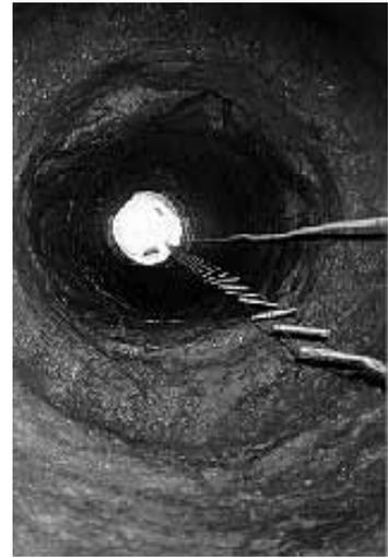
wurde. Die Verbindung Schacht 4 – Schacht 5 zeigt sehr deutlich, wie der Tunnel von Schacht 4 aus zentrisch aufgefahren wurde und wie Schacht 5 nördlich um fast 3 Meter verfehlt wurde. (Abb. 14)
