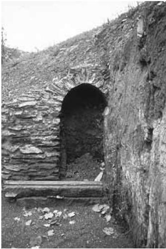
Abb. 4 Baulos A, Blick nach Süden auf moderne Einwölbung nach der Ausgrabung von 1987 über der geringen Überdeckung des Tunnels. Links im Hintergrund taucht der anstehende Schieferfels ab.
