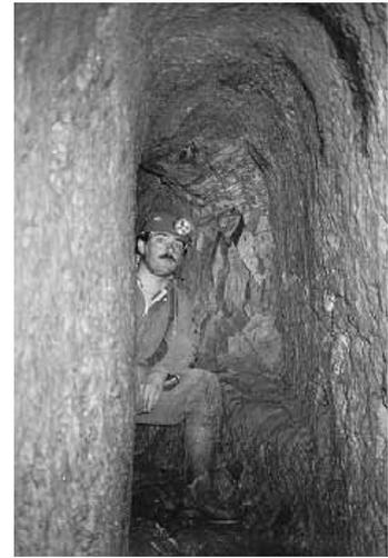
Abb. 15 Blick nach Norden auf die Ortsbrust von Baulos S mit Absatz der Tunnelsohle vor der Höhenangleichung mit Baulos T.
