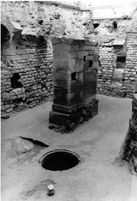
Abb. 5 Trier, Domfreihof, Turm Jerusalem. Neu entdecktes Freigeschoß: Blick auf Pfeiler von Südosten, davor der Vorratsschacht (Foto: ME 1999,96/33A - U. Spies).
