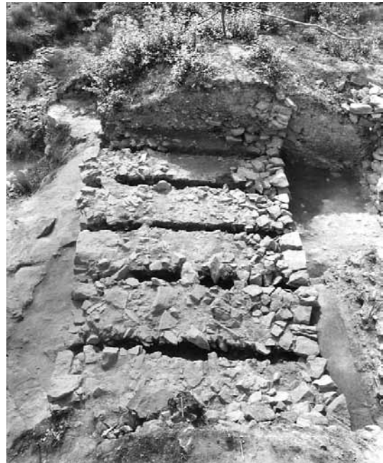
Abb. 21 Schnitt 1, Mauerplanum (Innenfront rechts) mit ausgeräumter Balkenlage I.
