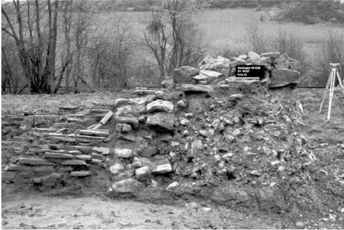
Abb. 18 S-N-Profil an der vom Bagger angeschnittenen nordöstlichen Ofenecke; links eine der Ziegelmauern, in der Mitte die nördliche Außenmauer der 1. Bauphase, rechts anschließend die Verstärkungsmauer der Phase 2. Die Unterkante der vorgeblendeten Mauer entspricht der damaligen Geländeroberfläche.
