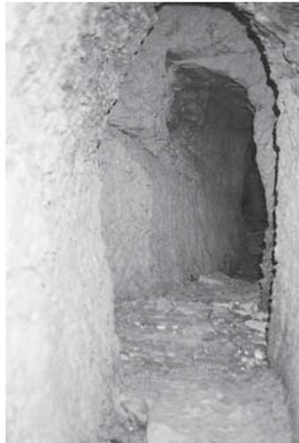
Abb. 21 Blick nach Süden auf Schacht 9. Auf der Sohle ist die Kanalabdeckung aus Muschelkalksteinplatten zu erkennen.
