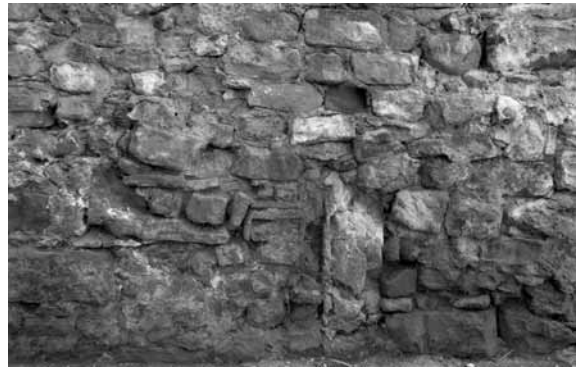
Abb. 9 Trier, Dietrichstraße 5. Mittelalterliche Mauer mit römischen Hohlziegeln (Foto: Th. Zühmer, ME 2002,106/8).
