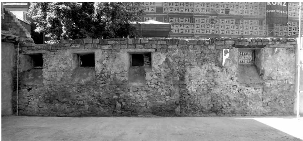
Abb. 8 Trier, Dietrichstraße 5. Mittelalterliche Mauer aus wiederverwendetem römischen Altmaterial (Foto: Th. Zühmer, ME 2002,106/2).
