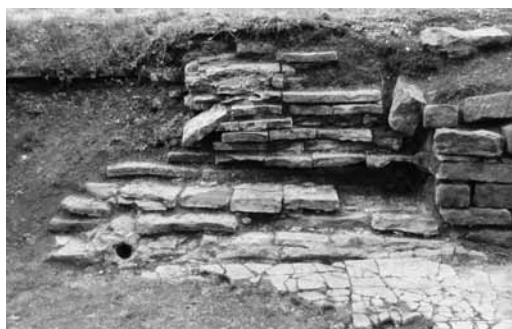
Abb. 4 Trier, Barbarathermen, Wanne N2 mit Rest der Treppe und Abflußrohr aus Blei, von Norden (Foto: M. Dodt, RE 2003/54, 35).
