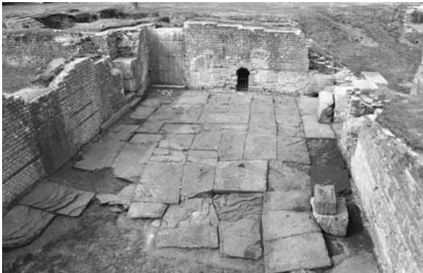
Abb. 5 Trier, Barbarathermen, Lichthof 25 mit freigelegtem Plattenboden, von Süden (Foto: M. Dodt, RE 2003/39, 21).
