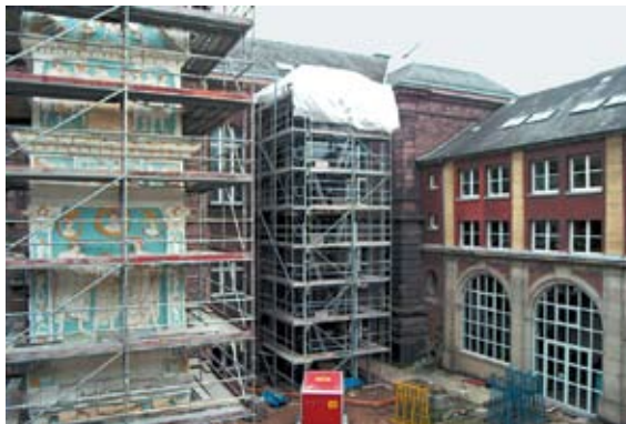
4 Einrüstung der Igeler Säule und Installation des Aufzugs im Innenhof, 2005.
