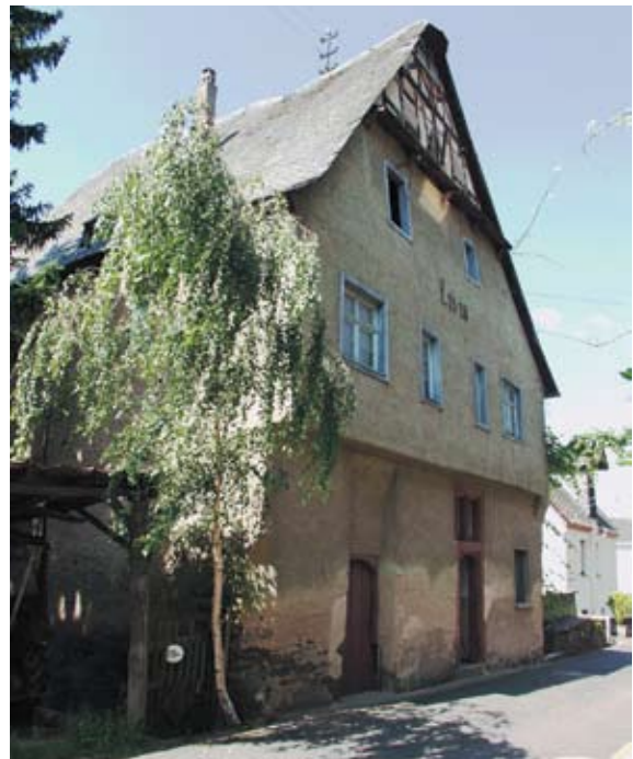
7 Merl, Im Spay 25. Giebelfassade.
