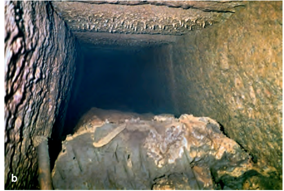
78 Trier, St. Barbaraufer/Ecke Kaiserstraße. Antiker Abwasserkanal mit tonigen Schlammablagerungen, Untersuchung von 1992. a Querschnitt (Zeichnung: B. Kremer). b Blick nach Osten in das Innere des Kanals (Foto: W. Jutz, Stadtwerke Trier).
