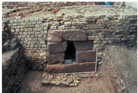
77 Trier, Simeonstift (ehemalige Eckverbindung zwischen West- und Nordflügel). Stollenähnliche Konstruktion aus monolithischen Sandsteinquadern im römischen Stadtmauerfundament (Foto: K. Bissinger, Dia).
