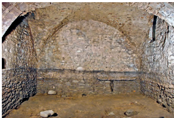
26 Trier, Dietrichstraße 5. Östliche Stirnwand des spätmittelalterlichen Kellers mit eingebautem Kaminofen (Foto: Th. Zühmer, Dia).
