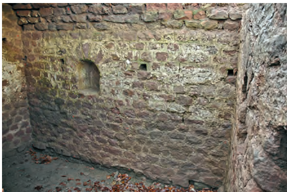
50 Trier, Friedrich-Wilhelm-Straße 29/31. Rotsandsteinkeller, Südwand mit Nische und Balkenlöchern (Foto: G. Breitner, Digi-EV 2007,93/475).
