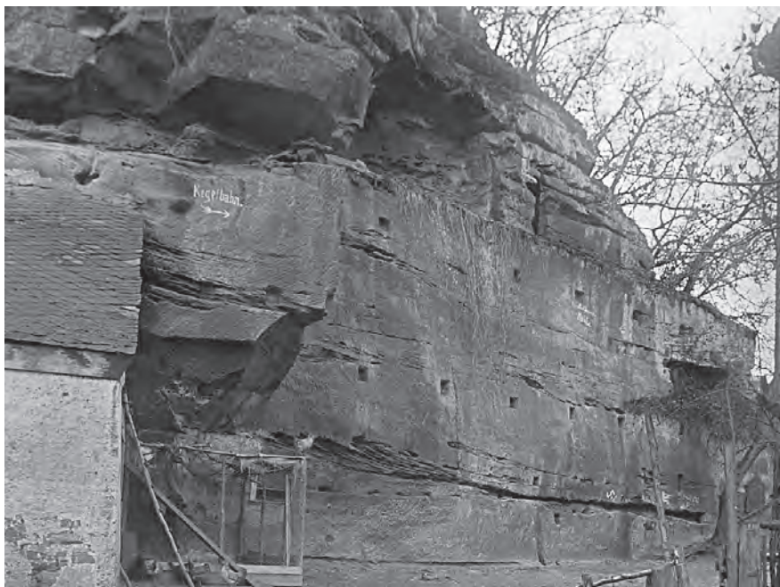
3 Trier, „Balduinshäuschen“. Abgeschrotete Felswand mit Balkenlöchern der ehemaligen Geschossebenen, Ansicht von Süden. Aufnahme von 1922 (Foto: RLM Trier, D 1726).
