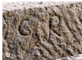
70 Trier, Porta Nigra. Steinbruchmarken in der untersten Quaderlage an der Westseite des Westturms (Fundamentbereich). a Ansicht von Norden. b-c Ausschnitte mit Steinbruchmarken (Fotos: J. Hupe, Digi-EV 2007,76/2.5.3).
