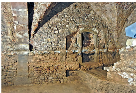
27 Trier, Dietrichstraße 5. Ursprünglicher Kellerzugang mit später eingefügtem Wandschrank (Foto: Th. Zühmer, Dia).
