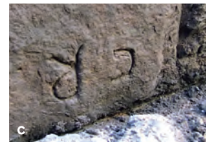
70 Trier, Porta Nigra. Steinbruchmarken in der untersten Quaderlage an der Westseite des Westturms (Fundamentbereich). a Ansicht von Norden. b-c Ausschnitte mit Steinbruchmarken (Fotos: J. Hupe, Digi-EV 2007,76/2.5.3).
