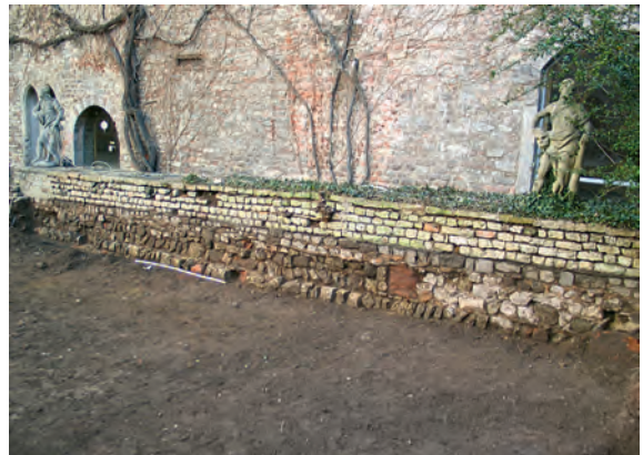
74 Trier, Simeonstift, Nordflügel. Obere Fundamentlagen der nördlichen Hofumgangsmauer mit neuzeitlich aufgemauert Brüstung (Foto: K. Bissinger, Dia).
