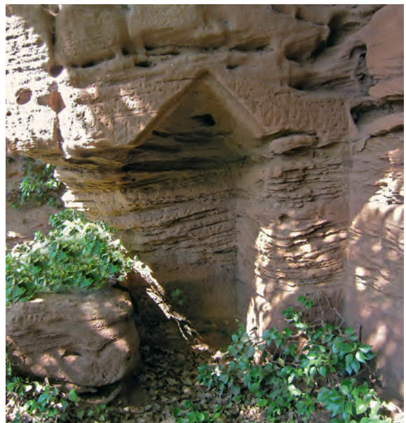
5 Trier, „Balduinshäuschen“. Wandnische in der Südwand der mittleren Kammer (Foto: B. Kremer, Digi-EV 2007,87/17).
