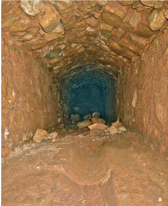
67a-b Trier, Medardstraße 2. Kanal aus Kalksteinmauerwerk mit innenliegender Rotsandsteinrinne (Fotos: G. Ziewers, Digi-EV 2004,80/11.3).
