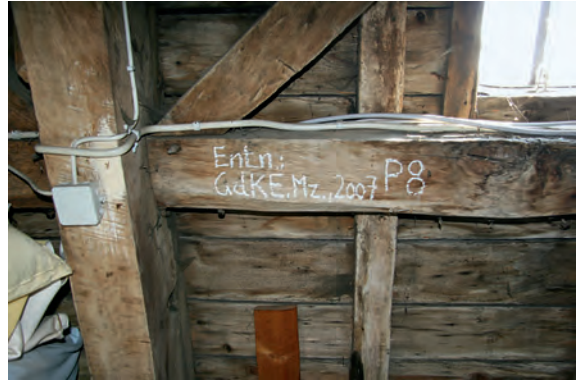
8 Lissingen, Burg. Dachgeschoss des Wohnhauses. Stuhlrahm, um 1785.
