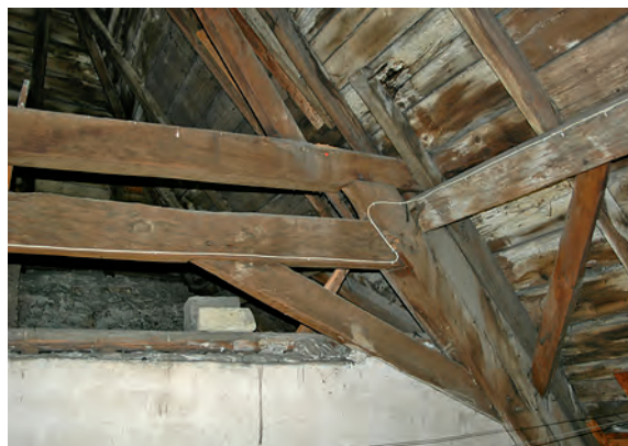
4 Grevenmacher, Grand rue 17. Dachstuhl, 1799/1805.
