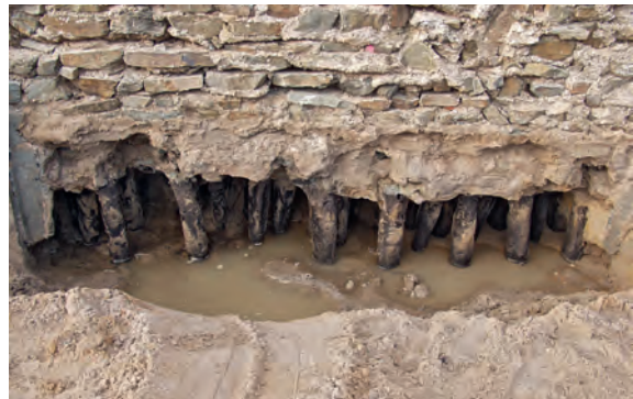
11 Xanten, Thermenanlage. Eichenpfahlrost, um 120-138 n. Chr.
