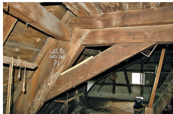
6 Kaisersesch, Koblenzer Straße 48. Dachgeschoss. Stuhlsäule vom Südwestgiebel, 1688/89.
