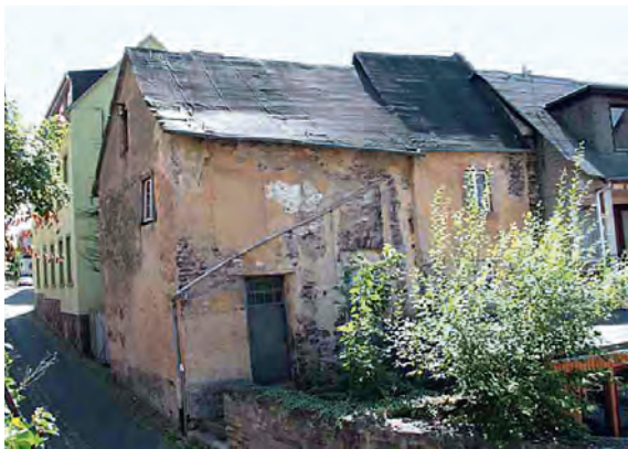
1 Bruttig, Hauptstraße 38. Nordseite.
