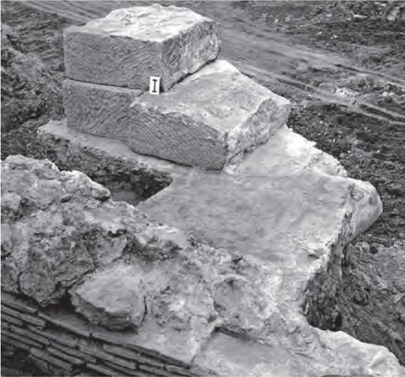
**66** Trier, Palastgarten/Tiefgarage. Gebäude 5, nördlicherer Gebäudeteil. Abgewinkeltes Pfeiler-/Säulenfundament I, der die westöstlich orientierte Spannmauer M4 trug. Ungefähr von Osten.
