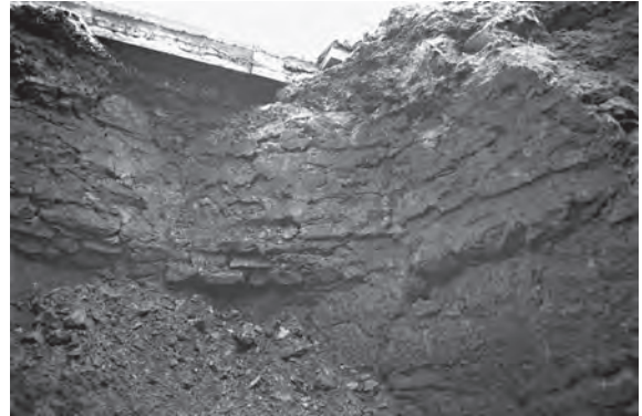
9 Burg Ottenstein. Südöstlicher Rundturm, Gewölbeansatz mit Abdruck der Schalbretter im Turminnenen.
