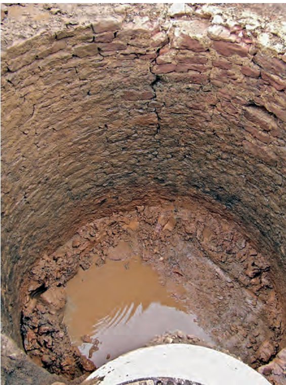
11 Burg Ottenstein. Nordöstlicher Rundturm, Untergeschoss nach erfolgter Freilegung.
