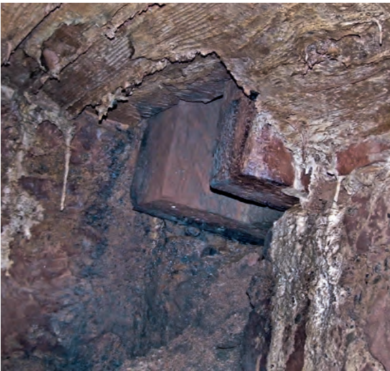
20 Burg Ottenstein. Austritt der Fallrinne in den Kanal [vgl. Abb. 19].
