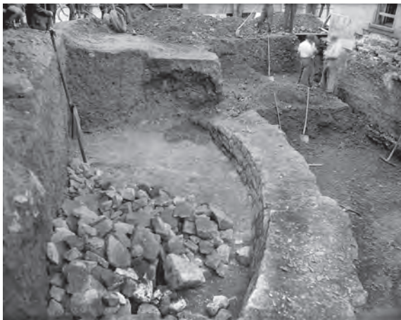
6 Wittlich, Schlossstraße. Baugrube für einen Erweiterungsbau an der Nordseite des Bahnhofs, 1938. Spätmittelalterliche Stadtmauer. Ansicht von Osten.
