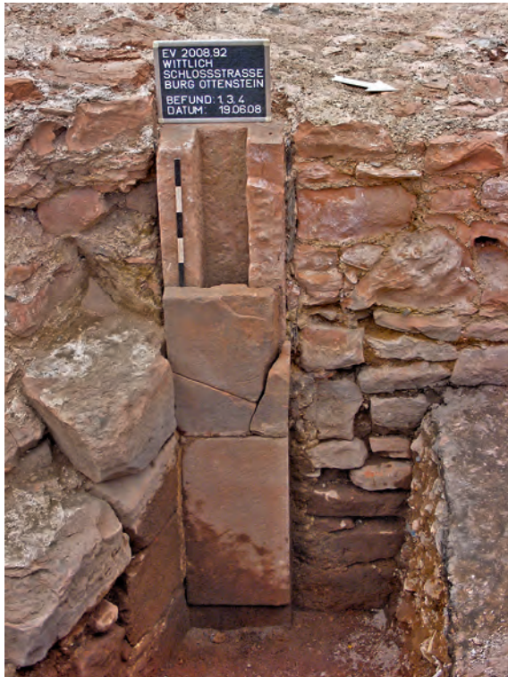
17 Burg Ottenstein. Fallrinne mit Abdeckplatten in östlicher Grundmauer der Burg (gebrochene obere Deckplatte teilweise wiedereingesetzt); links anschließend der Ansatz der Winkelbastion.
