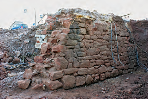
31 Wittlich, Schlossstraße. Überrest der spätmittelalterlichen Stadtmauer am nördlichen Widerlager der ehemaligen Bahnunterführung. Ansicht der Stadtseite.
