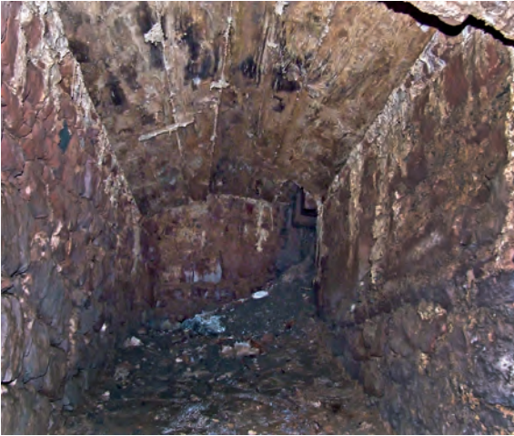
19 Burg Ottenstein. Kanalzulauf in die Wasserrückhaltekommer; hinten rechts im Bild die einmündende Fallrinne [vgl. Abb. 20]. Ablagerungen im Kanalinneren zum Zeitpunkt der Fotoaufnahme bereits teilweise ausgeräumt.
