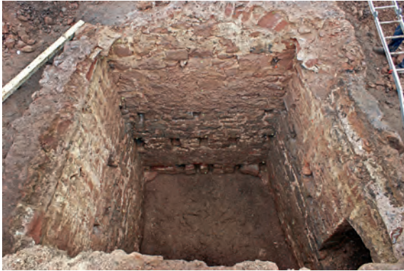
22 Burg Ottenstein. Wasserrückhalte­kammer mit Ansätzen des (bei der Auffindung noch unversehrten) Tonnengewölbes. Blick auf die Ostwand.
