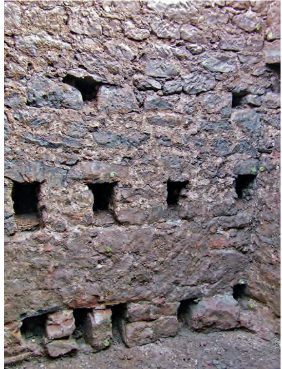
23 Burg Ottenstein. Wasserrückhalte­kammer, Maueröffnungen in der Ostwand (Ausschnitt).
