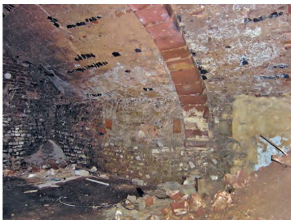
25 Trier, Rindertanzstraße 12. Mittelalterlicher Keller, Ostwand längs der Rindertanzstraße (Foto: B. Kremer, Digi-EV 2009,229/1).
