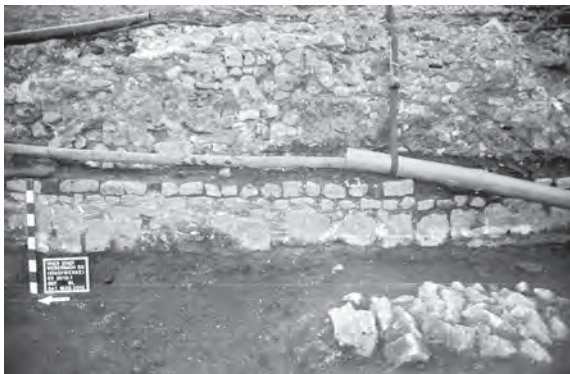
53 Trier, Weberbach 50. Fundamentsockel einer hochmittelalterlichen Mauer unter der Straßenfront des kriegszerstörten spätmittelalterlichen Hauses Weberbach 47/Ecke Kuhnenstraße (Foto: H. Comann, ME 2010,10/15).
