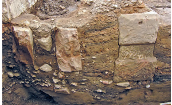
44 Trier, Weberbach 50. Fundamentsockel der Pfeilerportikus am Westrand der Nord-Süd-Straße H mit daran anstreichenden Bauhorizonten und Laufniveaus; im Bild links Sandsteinwangen eines später angelegten Kanals, Teilprofil mit Blick nach Süden (Foto: H. Comann, Digi-EV 2010,1/299).
