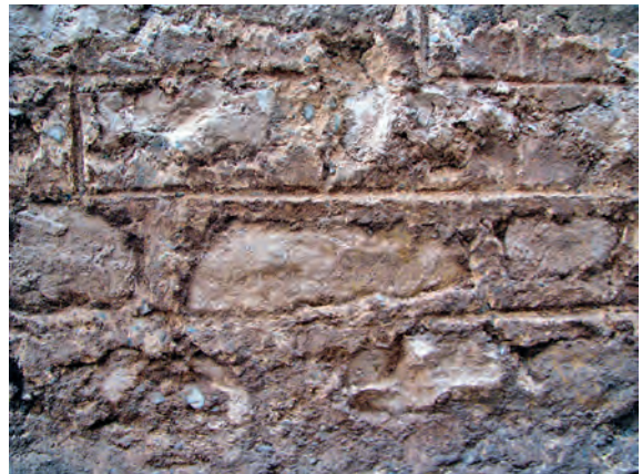
21 Trier, Neustraße 85-87/Viehmarktplatz 3-5. Kalksteinmauer mit Fugenstrich, Detailaufnahme (Foto: U. Spies, Digi-EV 2009,96/61).
