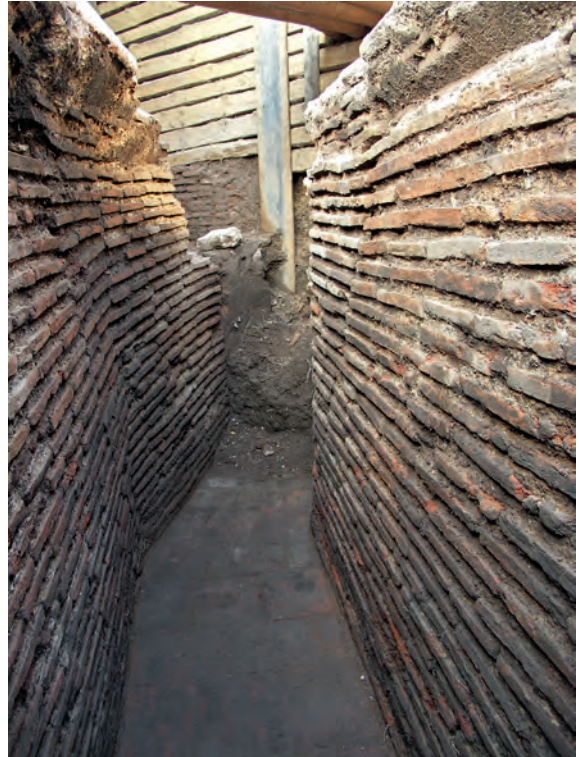
50 Trier, Weberbach 50/Ecke Wechselstraße. Blick nach Norden in den freigelegten Ziegelkanal, Zustand nach Abtragung des Gewölbescheitels (Foto: H. Comann, Digi-EV 2010,1/456).
