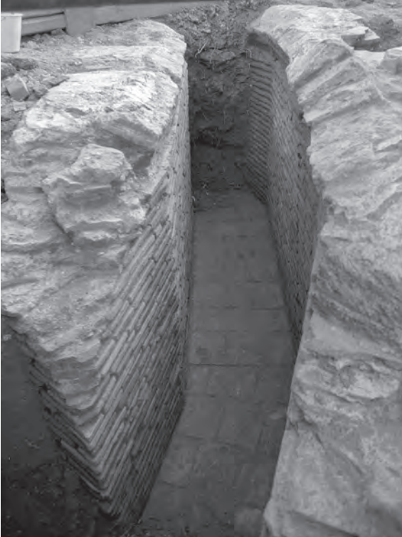
51 Trier, Weberbach 50/Ecke Wechselstraße. Blick nach Südosten in den freigelegten Ziegelkanal, Zustand nach Abtragung des Gewölbescheitels (Foto: H. Comann, RE 2010,46/17).
