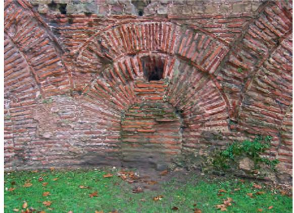
**48** Trier, Kaiserthermen. Zugemauerte Rohbauöffnung mit Loch für ein Abflussrohr in Apsis b', von Norden (Foto: M. Dodt, Digi-EV 2010,163/183).
