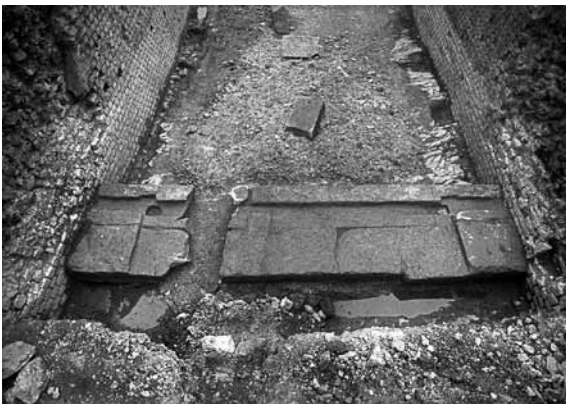
25 Trier, Amphitheater, Nordseite. Torschwelle im Arenazugang, 1911, Aufsicht.
