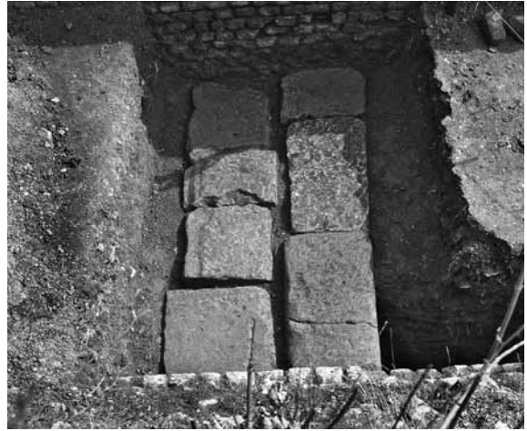
26 Trier, Amphitheater, Nordseite. Quadersetzung in Vomitorium 5, 1977.
