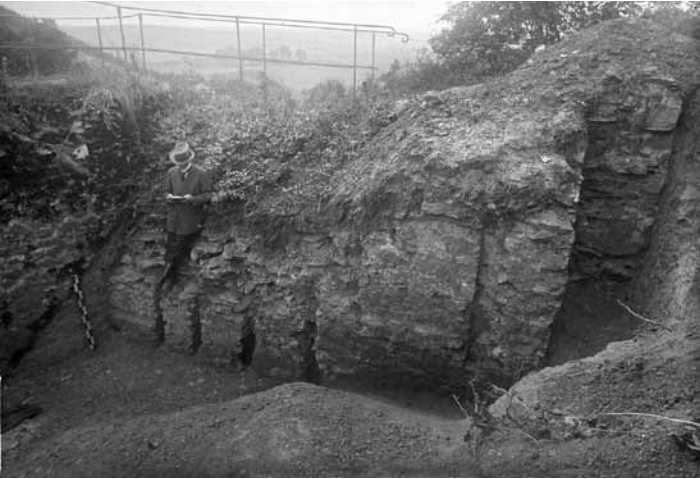
8 Trier, Amphitheater, Südseite. Fundament des südlichen Eckturms der Stadtmauer, Nordansicht mit Abdrücken der Verschalung, 1923. Im Bild rechts das Widerlager des Bogens an der Westseite, links das Halbrund des dortigen Stützzylinders.
