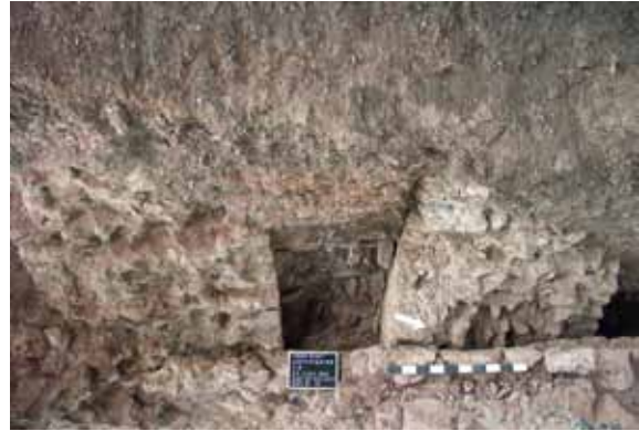
20 Trier, Amphitheater, Nordseite. Schieferfundament der Stadtmauer zwischen den Erddruckbögen von V5, Aufsicht, März 2013.
