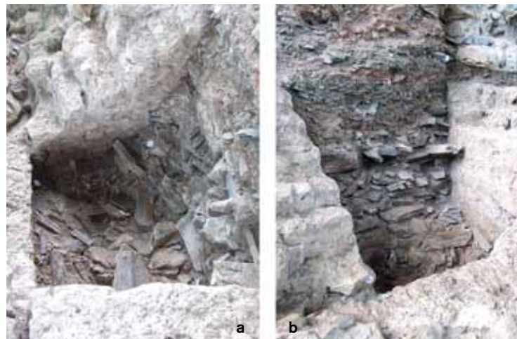
21 Trier, Amphitheater, Nordseite. Schieferfundament zwischen den Erddruckbögen von V5, März 2013. a Detail mit Nahtstelle an Bogenaußenschale. b Fundamentaufbau im Querschnitt.
