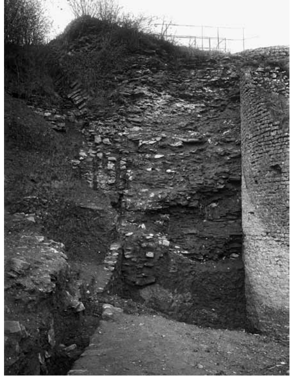
12 Trier, Amphitheater, Südseite. Südansicht des Eckturmfundaments mit davorliegender Aussparung in der Stadtmauer, 1928.
