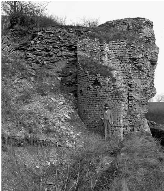
5 Trier, Amphitheater, Südseite. Südlicher Druckbogen am Zuschauerengang V2 mit anstoßendem Turmfundament der Stadtmauer, undatiert (um 1904 inventarisiert).
