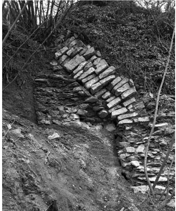
14 Trier, Amphitheater, Südseite. Bogenansatz mit Auflager am südlichen Eckturm der Stadtmauer. Blick nach Norden, 1966.
