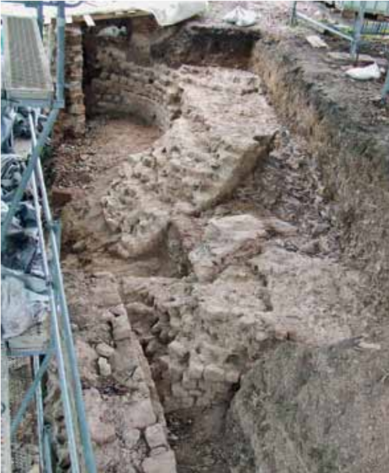
19 Trier, Amphitheater, Nordseite. Gemauerte Erddruckbögen von V5 mit dazwischenliegendem Schieferfundament der Stadtmauer, Blick nach Süden, Januar 2014.
