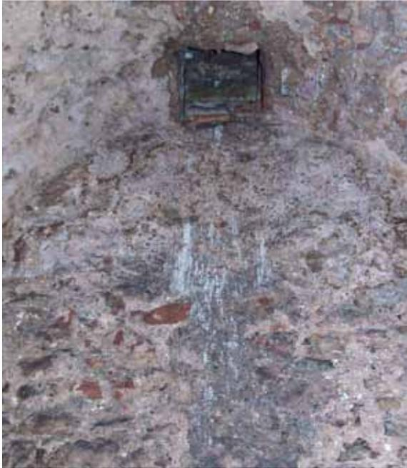
**30** Trier, Glockenstraße 12. Obere Kammer der Latrinenanlage, Nordwand mit Mündungsöffnung eines Fallschachtes im Gewölbescheitel (Foto: J. Hupe, Digi-EV 2013,155/163).
