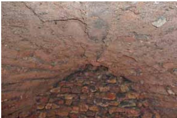
**27** Trier, Glockenstraße 12. Tonnengewölbe des spätmittelalterlichen Latrinenschachtes mit Mörtelabdrücken von Schalbrettern eines Leargerüsts. Hinten im Gewölbescheitel die Aufstiegsöffnung zur oberen Kammer der Abortanlage (Foto: J. Hupe, Digi-EV 2013,155/142).
