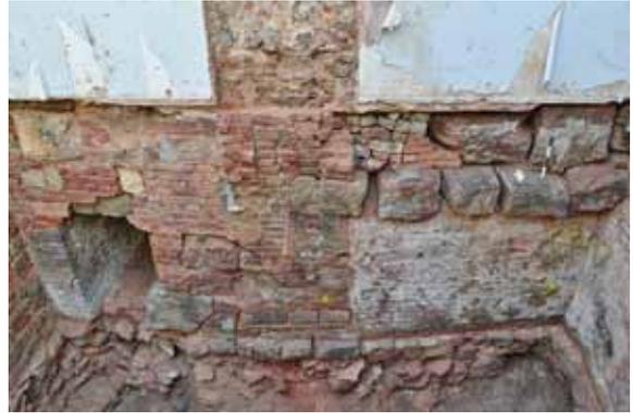
**18** Trier, Glockenstraße 12. Quadermauerwerk der ‚Ludolf'schen Mauer‘ (Dombering) mit neuzeitlicher Überformung im Kellergeschoss des Hinterhauses, Zustand nach Abbruch der Kellerdecke und Niveauabsenkung für den Neubau (Foto: M. Thiel, Digi-EV 2013,155/183).
