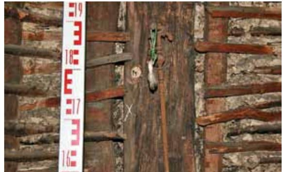
4 Braubach, Unteralleestraße 6. Holzbalken mit Probeentnahmestelle zwischen Gefachen mit Astgeflecht und Lehmverfüllung, 1570/71.
