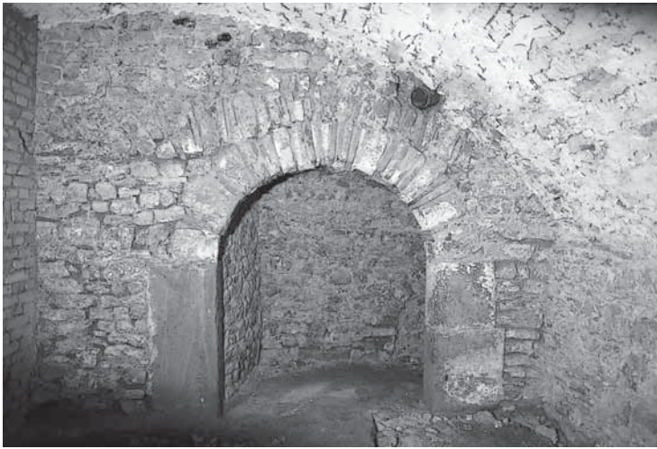
Abb. 13 Trier, Neustraße 43. Hochmittelalterliche Kellerwand mit romanischem Türbogen aus antikem Abbruchmaterial (Dia: RLM Trier - Th. Zühmer).
