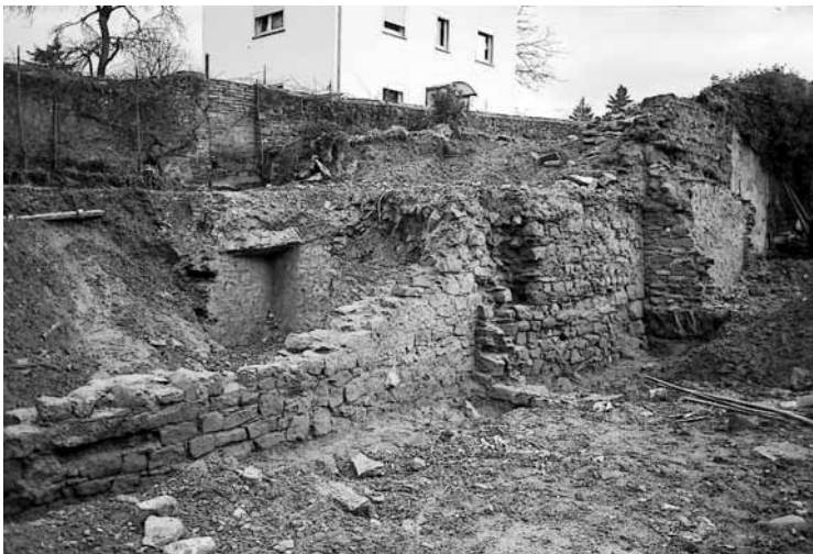
Abb. 28 Wittlich. Mauerzüge von Wohn- und Wirtschaftsgebäuden des 19. Jahrhunderts (Dia: RLM Trier - B. Kremer).
