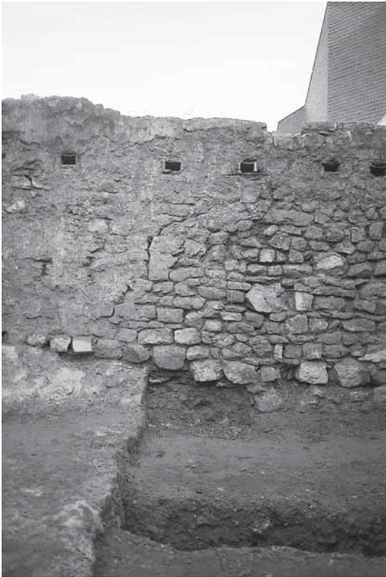
Abb. 17 Trier, Neustraße (Gelände der ehemaligen Firma Heil). Hochmittelalterlicher Keller mit wiederverwendeten Tubuli als Balkenlager (Dia: RLM Trier - B. Kremer).
