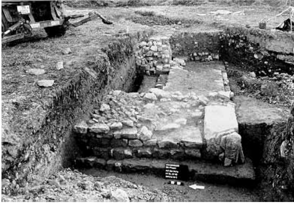
Abb. 16 Dockendorf. Südwestecke der Turmburg. (Foto: ME 1998,4/37 - B. Kremer).
