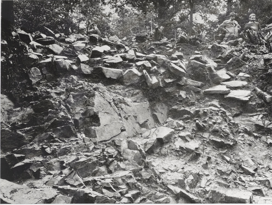
Abb. 21 Weiersbach, Altburg, Außenseite der Vormauer, auf Fels gebaut, Schnitt VIII
