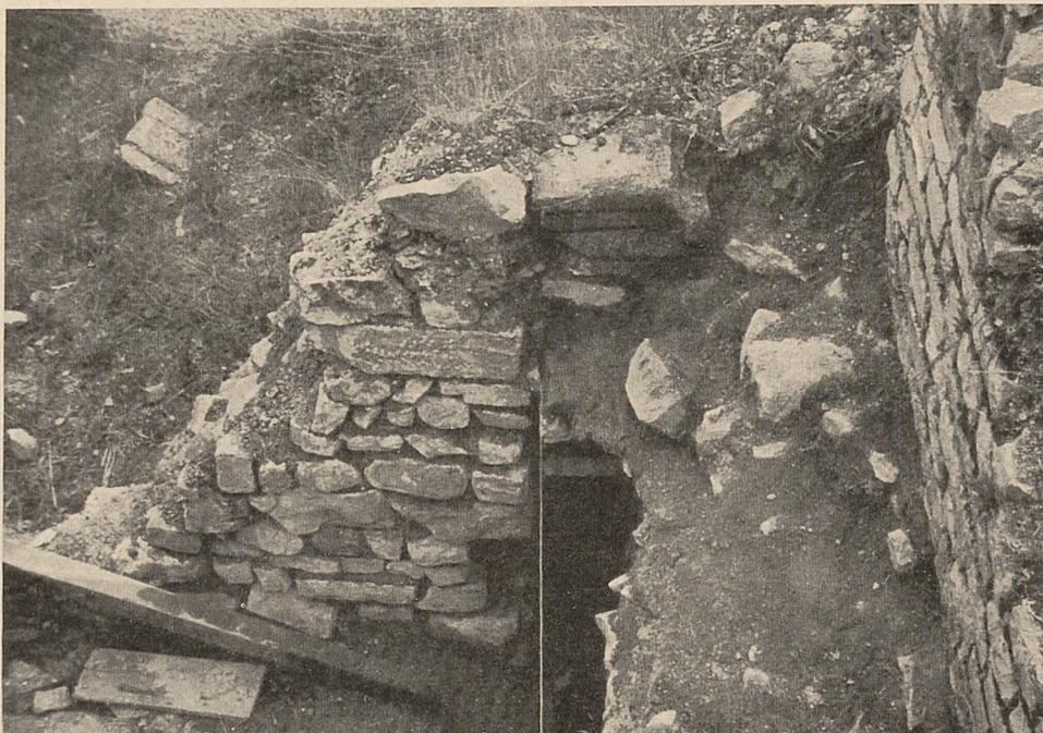
Abb. 3. Ansicht der Westseite des Treppeneinbaus. Von r. n. l. Stützmauer eines Ladens neben dem Durchgang zum Treppenabgang. Doppelmauer mit durchschnittenem Trockenkanal und darüber Ansatz des Entlastungsbogens aus Kalkstein und Ziegelplatten
