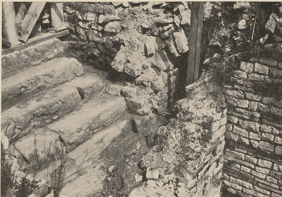
Abb. 2. Ansicht der Ostseite des Treppeneinbaus. Von r. n. l.: Ostwand der Rechteckkoje A 1, Reste der später eingebauten Stützmauer nach Aufgabe des Treppenabgangs, Doppelmauer mit durchschnittenem Kanal. 6 Treppenstufen und Reste des Verblendmauerwerks des Treppenhauses
