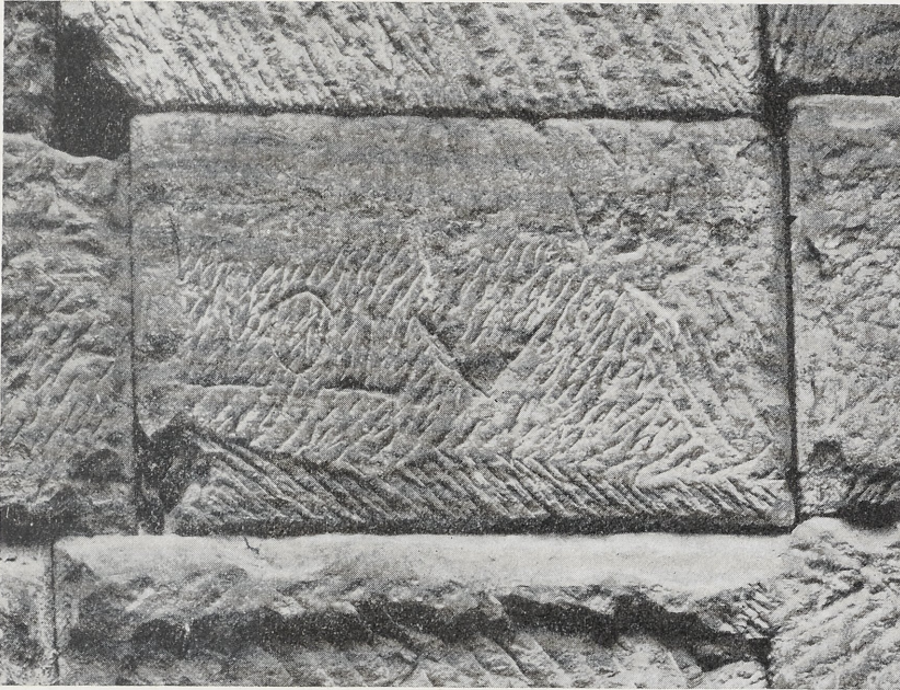
Abb. 4. Porta nigra, Trier. Ostmauer des Westturms, im Torhof. Marke ATOT auf dem Kopf stehend
